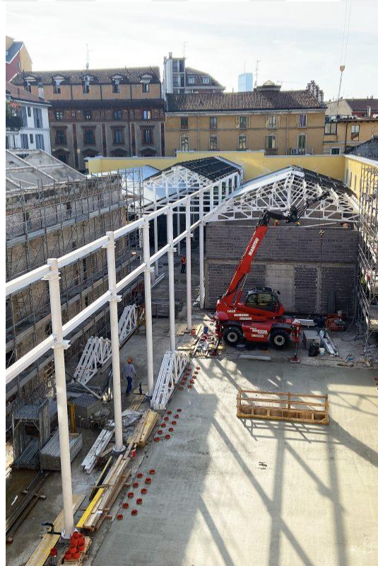
Şekil 55. ADI Tasarım Müzesi Yenileme Çalışmaları
