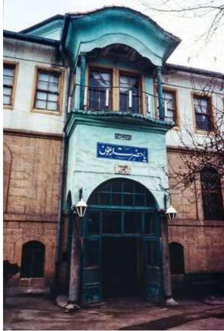
Şekil 15: Kütahya Mevlevîhanesi'nin cümle kapısı. Kaynak: Parlak, Tanrıokur, DİA.
