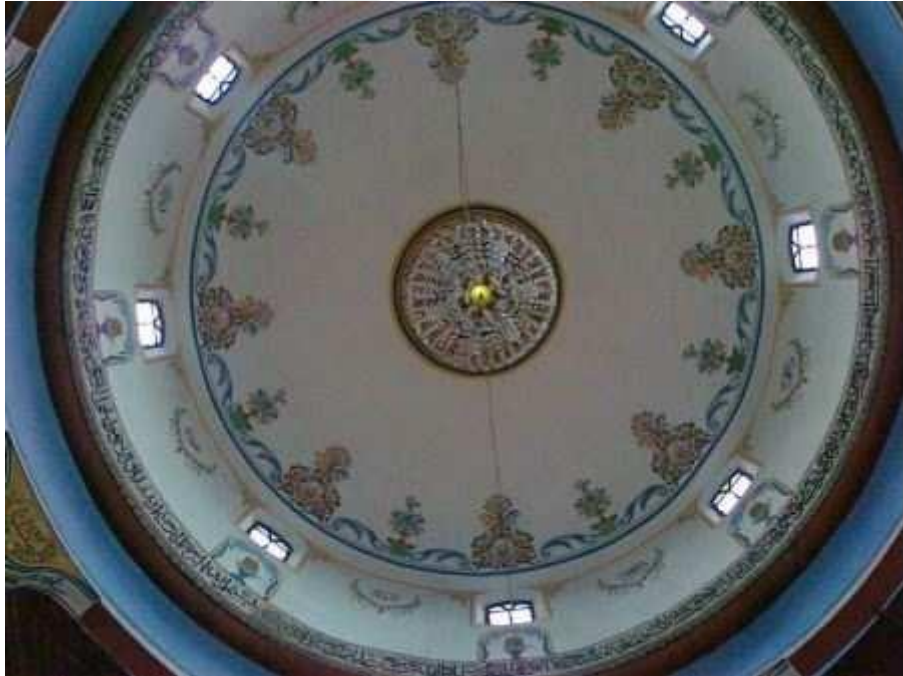
Ek 4: Mevlevîhane'nin kubbesinin iç görünümü. Kaynak: Anık, 2011.
