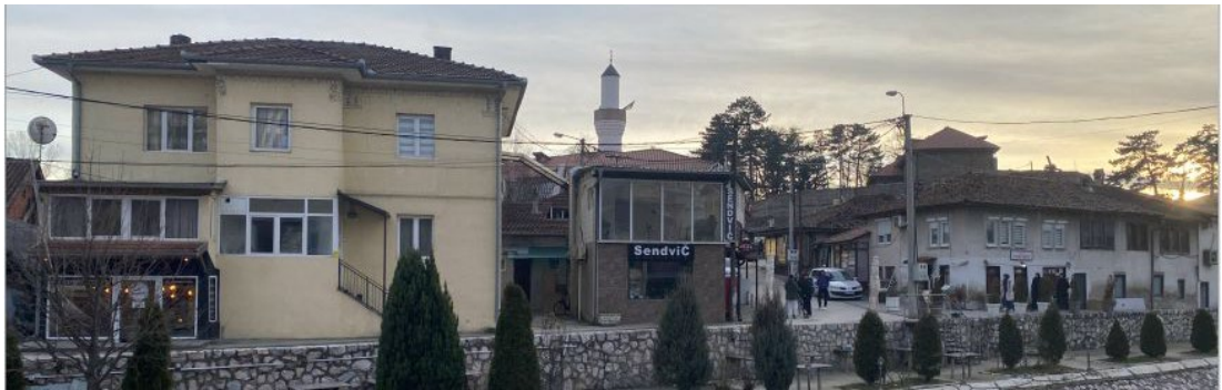
Şekil 4.18 : Solda Musevi evi, eski çarşı ile Arap Camii'nin minaresi ve en üstte, içinde eski Osmanlı surlarının bulunduğu şehir parkı içindeki kütüphane.
