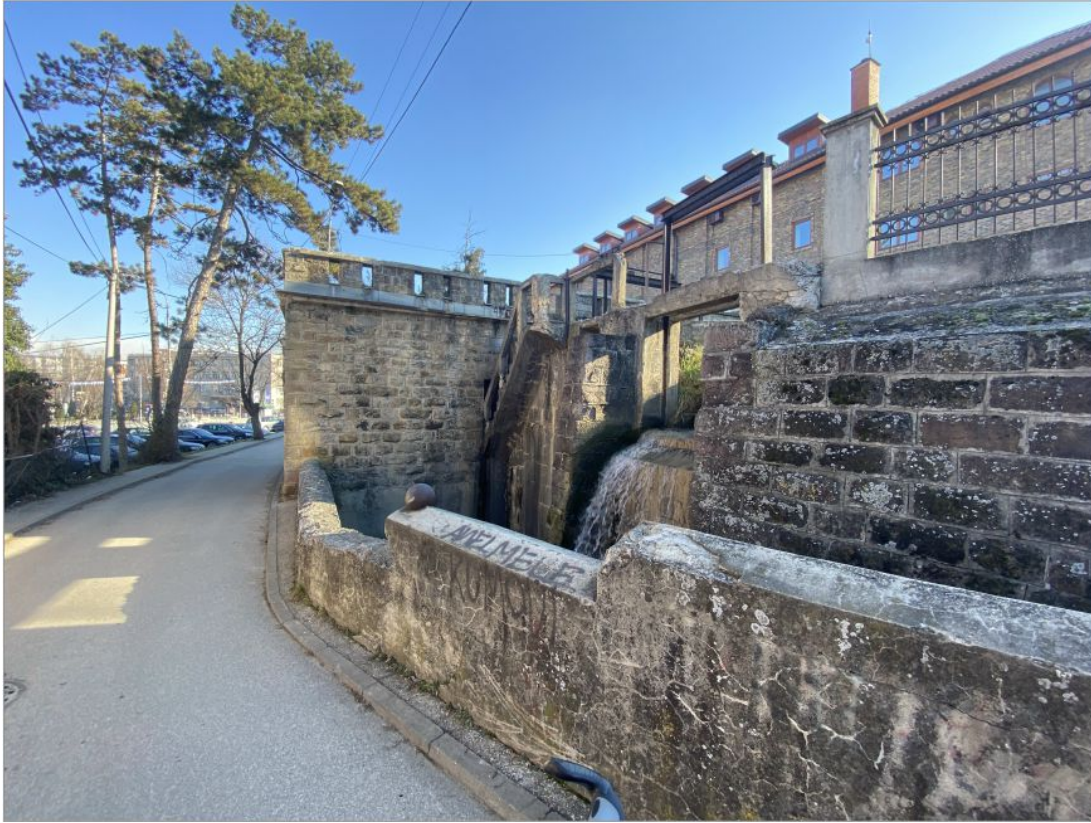
Şekil 4.24 : Tarihi kanal "Jaz"dan "Sancak" hidroelektrik santraline gelen su. Osmanlı surlarının yanında inşa edilmiştir. Tahkimatın tepesinde şehir kütüphanesinin binası bulunmaktadır.
