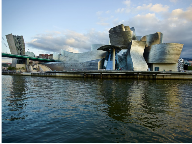
Şekil 2.28 Bilbao'daki cephesinde titanyum levhalar ile adeta bir renk şöleni yaşatılan Guggenheim Müzesi projesiyle cephedeki özgünlük, yaratıcılık ve bitiriliş tekniği yönünden Frank O. Gehry'nin dünya çapında ün kazandığı açıktır (divisare, 2015).
