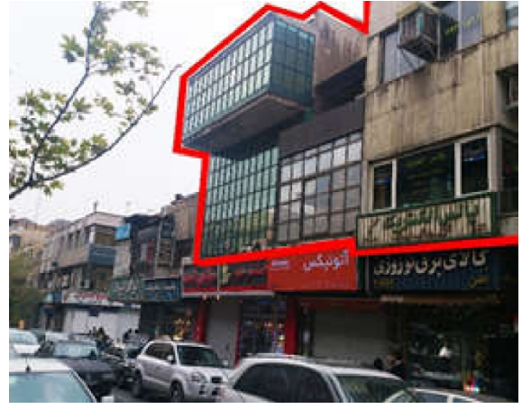
Şekil 6.9 Cephelerde kullanılan uygun olmayan ruhsuz renkleri; Gölşehir Bölgesi, Karaj.
