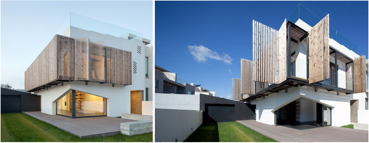
Şekil 2.4 Binanın gerçek yapısı ve bulunduğu çevre ile etkileşime giren bir dinamik cephe görünümünü sunan özel bir konut, Miramar, Portekiz (e|348 Arquitectura, 2014).
