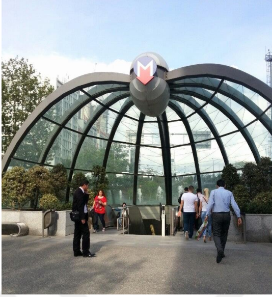
Resim 9. Windowist Tower Metro Girişi ve Çıkışı
