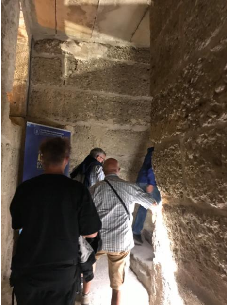
Resim 3.7. a) Sahne binası merdivenleri iç görünüm
