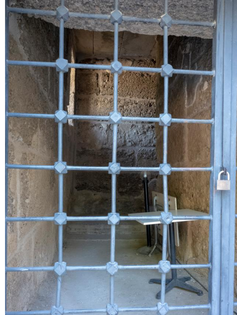
b) Sahne binası merdivenleri dış görünüm
