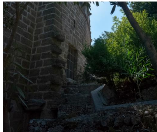
b) Geçit kapısı dıştan görünüm
