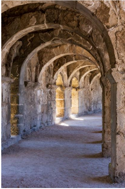
Resim 3.3. a) Tonozlu üst galeri
