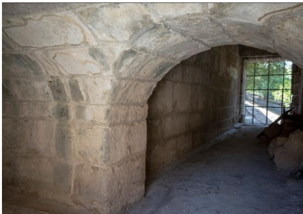
Resim 3.2. a) Geçit kapısı içten görünüm
