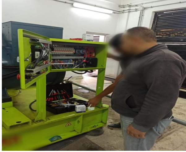
Şekil 25: Yıllık Bakımı Yapılan Jeneratör
