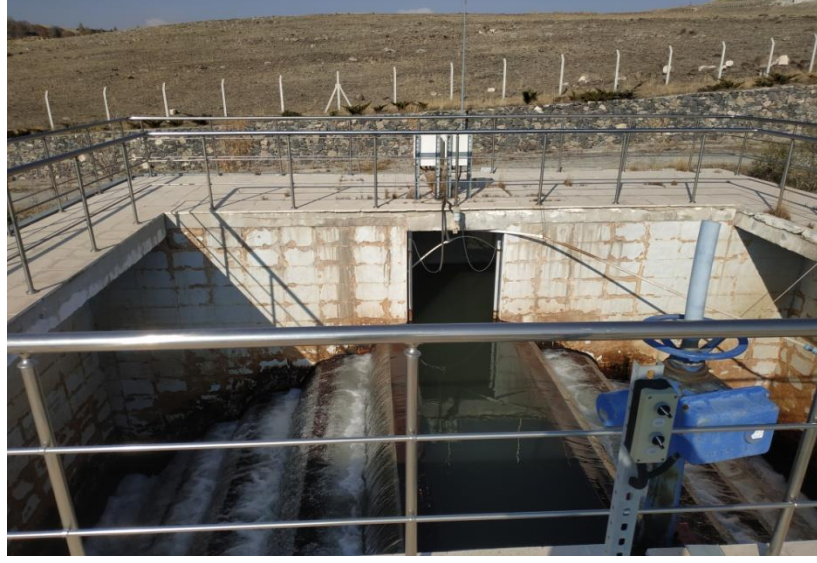
Şekil 27: Havalandırma Ünitesi Korkulukları
