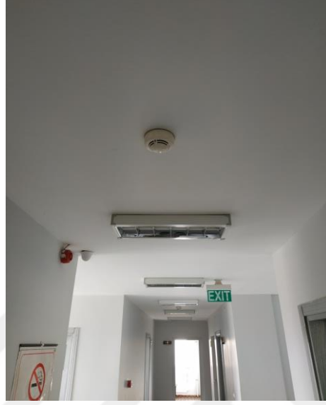
Şekil 21: Yangın Dedektörleri, Duman Dedektörleri ve Çıkış Levhaları
