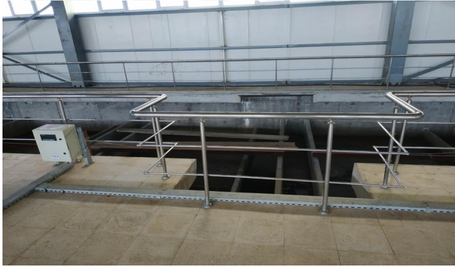
Şekil 28: Durultucu Havuz Korkulukları
