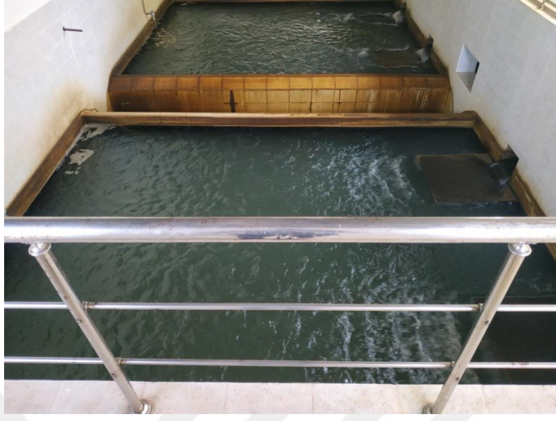
Şekil 29: Filtrasyon Havuz Korkulukları
