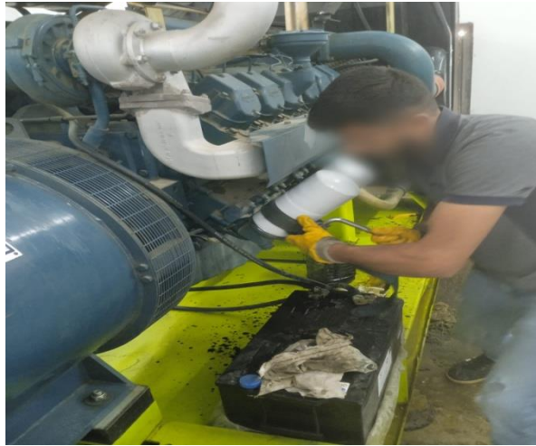
Şekil 24: Yıllık Bakımı Yapılan Vinç
