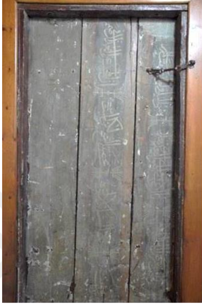
Şekil 3.30. Güney cephe minber yanı dehlize açılan kapı (Hünkar kapısının kanat kısmı)
