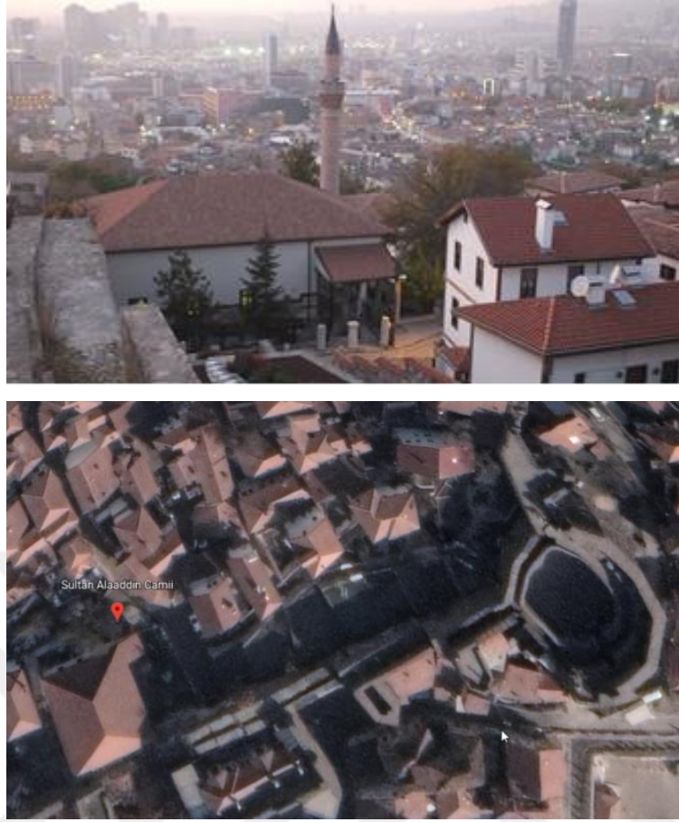
Şekil 3.2. Ankara Alaaddin Cami ve etrafındaki yapılar (VGM, 2022;Google Earth, 2022).
