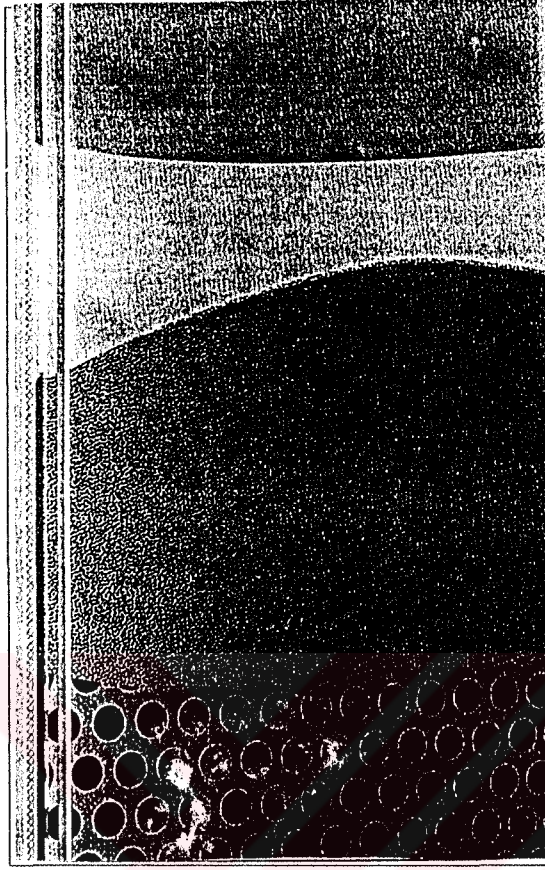
Şekil 5.30. Cam Yüzeyinde Emaye Boya Uygulaması (Delogcolor,1998).
