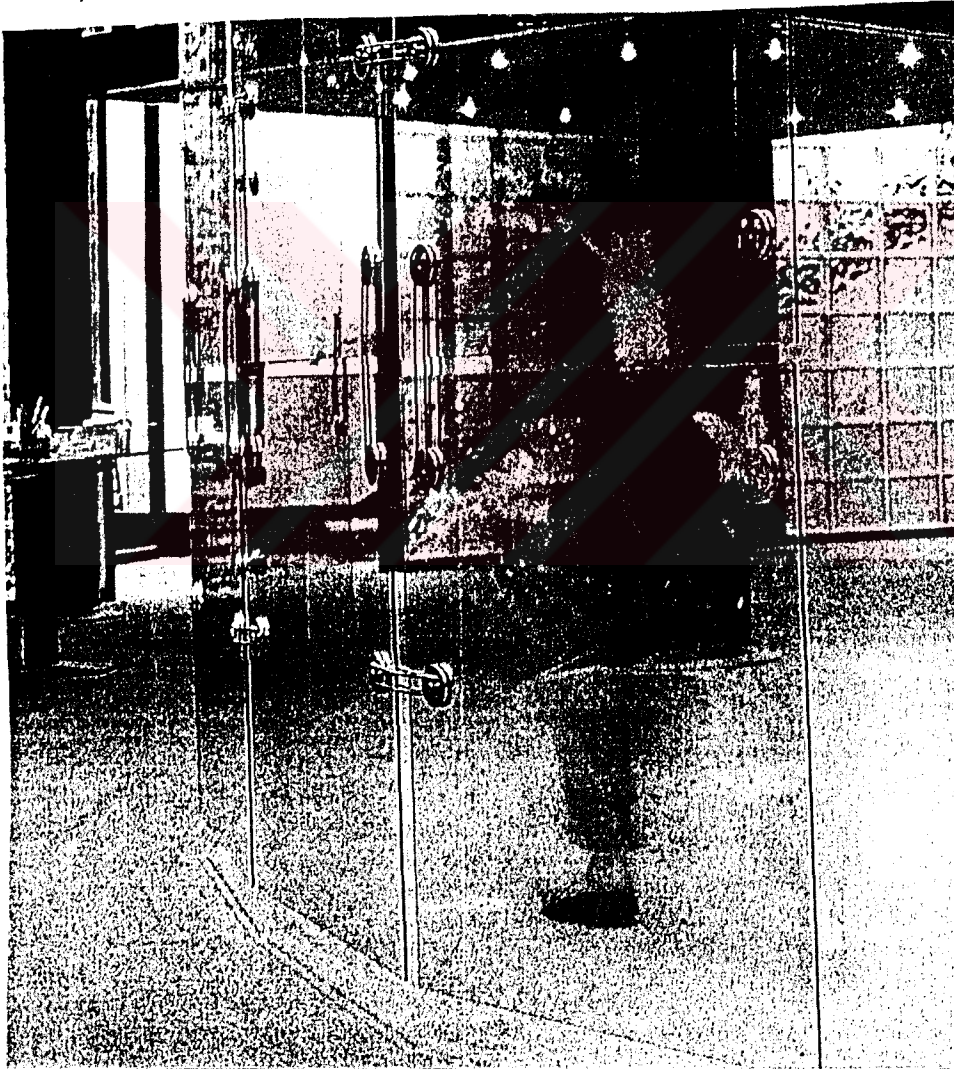
Şekil 5.31.Tasarımcı Reşit Soley - Noktasal Tespit Elemanları İle Kurulan Pano Cam Bölücü Elemanla Eğrisel Bir Hat Oluşturulması (Soley, 1990)
