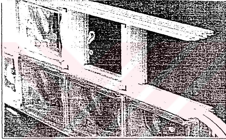
Şekil 6.36. Profilli Plastik Elemanların İçine Fiber Optik Kabloların Yerleştirilmesi (Circle 201, 1997)
