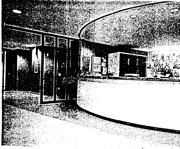
Şekil 5.10.Tasarımcı Fredy Schenkel- İsviçre’de Bulunan Bir Sağlık Merkezinin Danışmasında, Kullanım Güvenliği Ve Görsel Bütünlük Sağlayan Ön Gerilmeli Camların, Bir Yay Oluşturacak Şekilde Kavislendirilerek Cam Bölücü sistem İçinde Kullanılması ( Schenkel, 1997)
