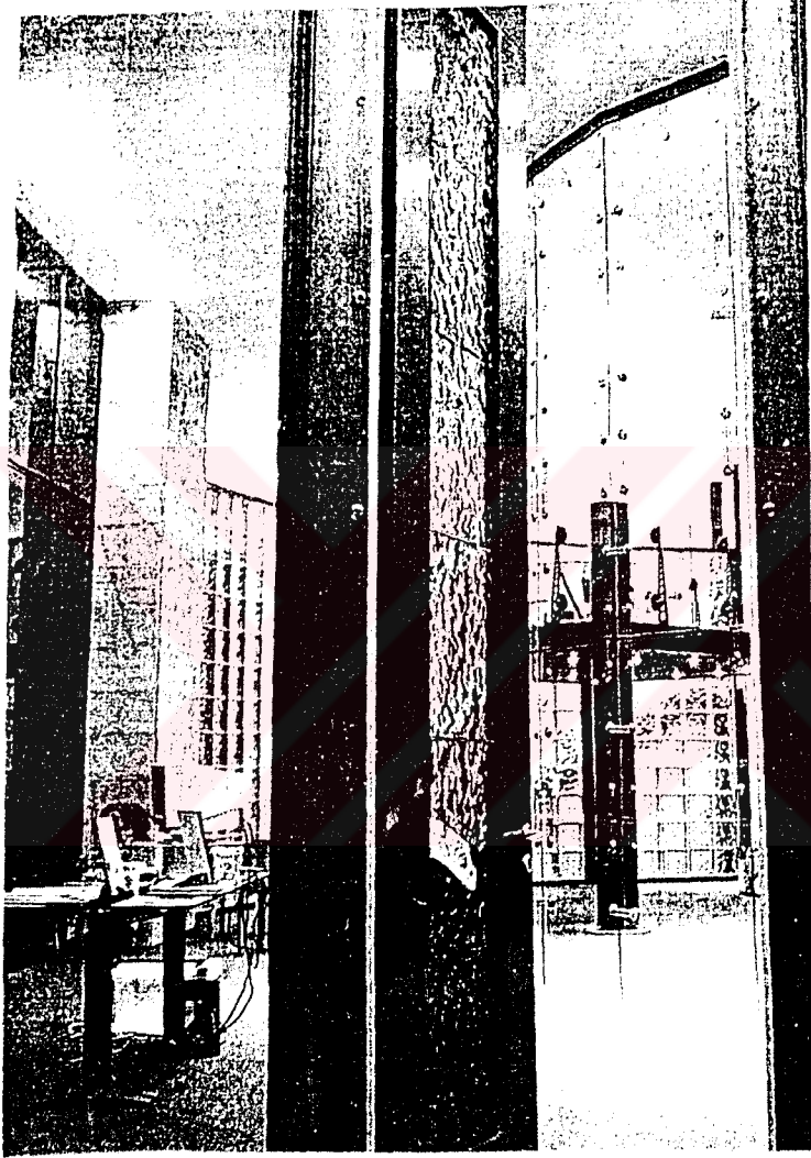
Şekil 6.17 .Tasarımcı Reşit SOLEY- Küçük boyutlardaki Çok Sayıda Levha Cam Tabakalarının noktasal tespit elemanları kullanılarak bir araya getirilmesi ile oluşturulan cam bölücü elemanda şeffaflığının, kullanıcı tarafından algılanabilir hale gelmesi (Soley, 1990)
