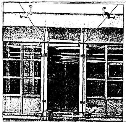
Şekil 6.16. İki Mekan Arasında Şeffaf Bir Bağlantı Kurmak Amacı ile Tavan Ve Yan Duvarlarında Cam Levhaların İki Kollu Noktasal Tespit Elemanları Kullanılarak Bir Araya Getirildiği, Cam Tünel (Vegla, 1998)
