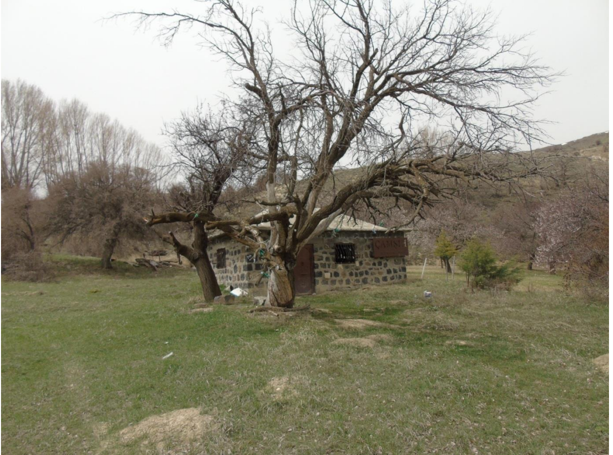
Fotoğraf 6. Kürecik Duruluova Mahallesiinde bulunan Çamşılı Türbesi Dış Taraf
