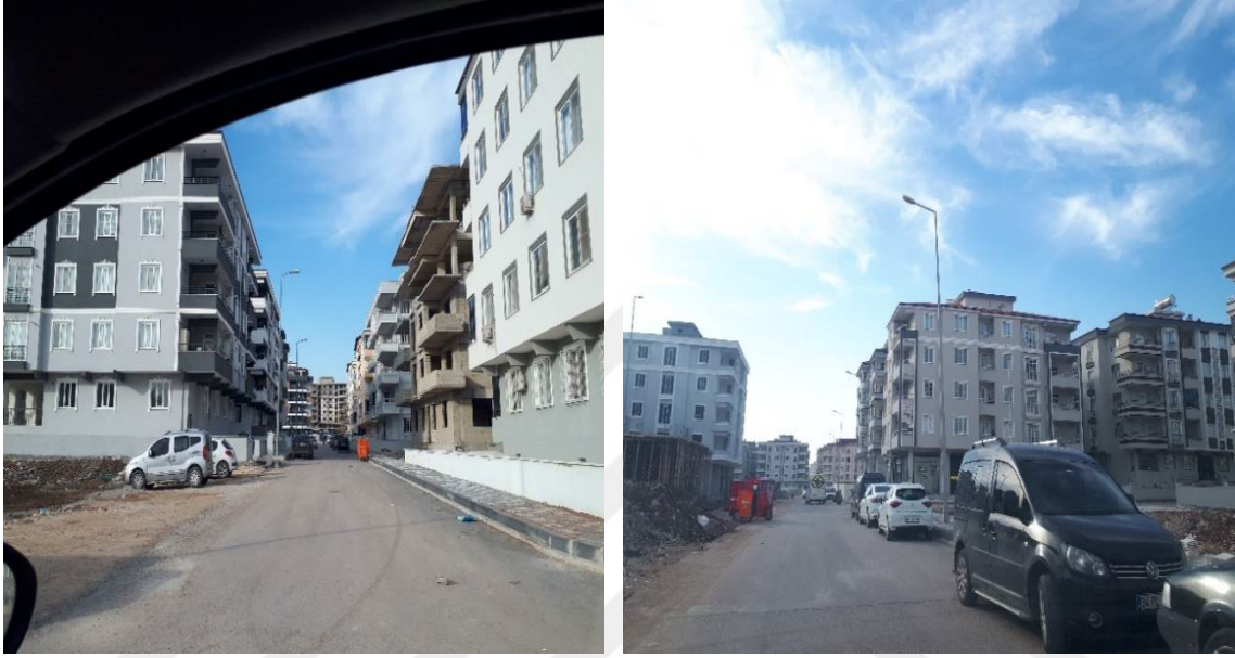
Şekil 58. Suçun düşük düzeyde olduğu bölgeler; yapılaşma
