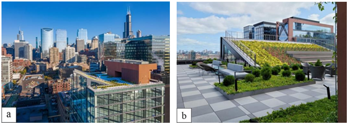
Resim 4.5. Fulton East Ofis Binası (a) çatı görünüşü (b) yeşil teras çatı [129]
