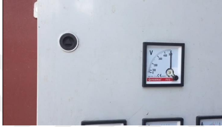
Şekil 3.103. Dalga Enerjisi Çevirici (DEÇ) sisteminin çalışma esnasında elektrik elde edilme durumundaki fotoğrafı.
