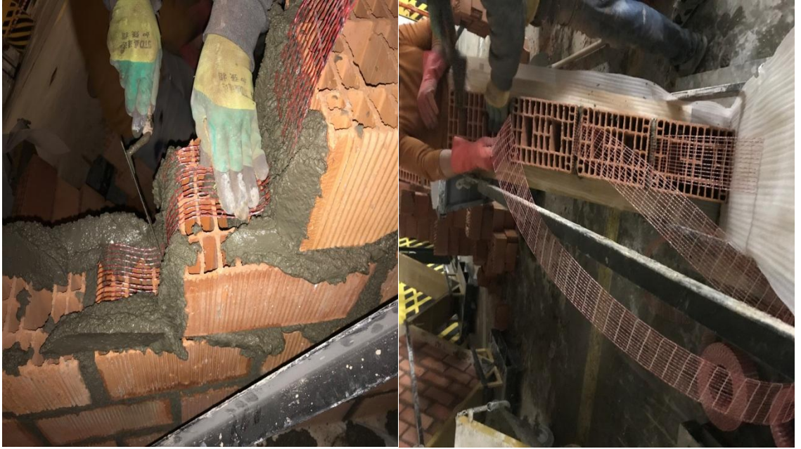
Şekil 19. Yığma Tuğla Dizilim-4'ün Yapımı
