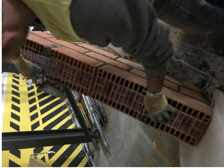
Şekil 13. Yığma Tuğla Dizilim-1'in Yapımı
