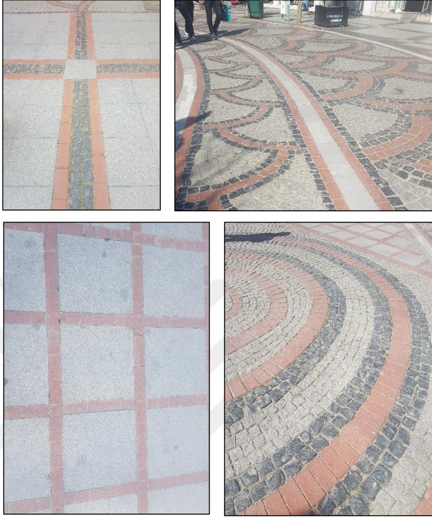
Şekil 7. 6. Zemin döşemesi (Fotoğraf: Ecem Paşalı, 2022).
