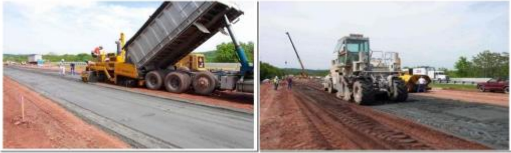
Fotoğraf 2.3. Zemin Uçucu Külün Zemin Uygulanması (Aygün, 2019)
