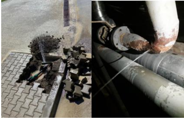
Resim 2.10. Boru arızalarından çevreye sızan sular
