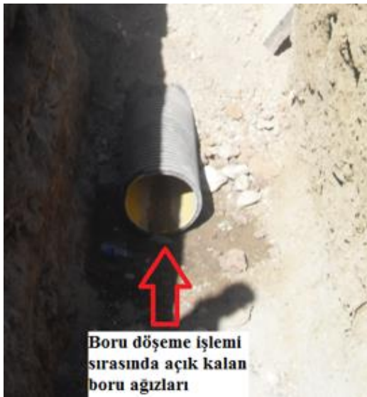
Resim 2.11. Boru döşeme işleminde açık kalan boru ağzı
