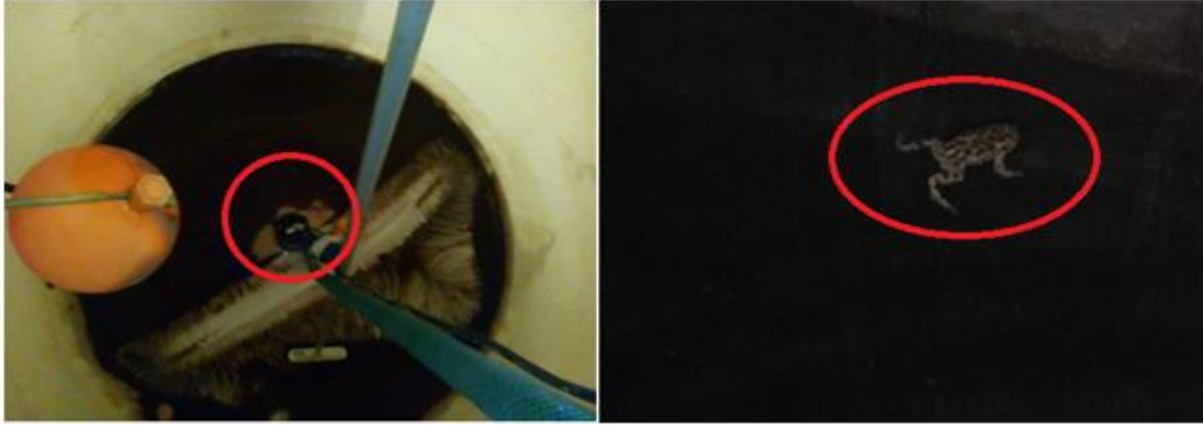
Resim 2.9. Yalıtımı yapılmamış su deposuna giren canlılar
