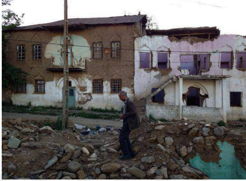
Şekil 4.5: Kale Mahallesi yıkım süresinde konutlar (Muş Kültürü Derneği, 2013)
