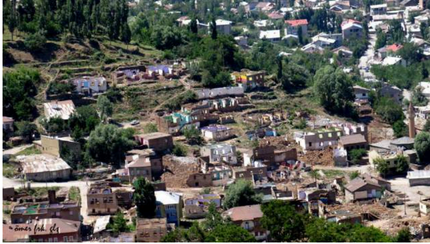
Şekil 4.8: Kale Mahallesi kentsel dönüşüm projesi kapsamında geleneksel konutların yıkım aşaması, güney tarafından bakış (Gülşen, 2013)
