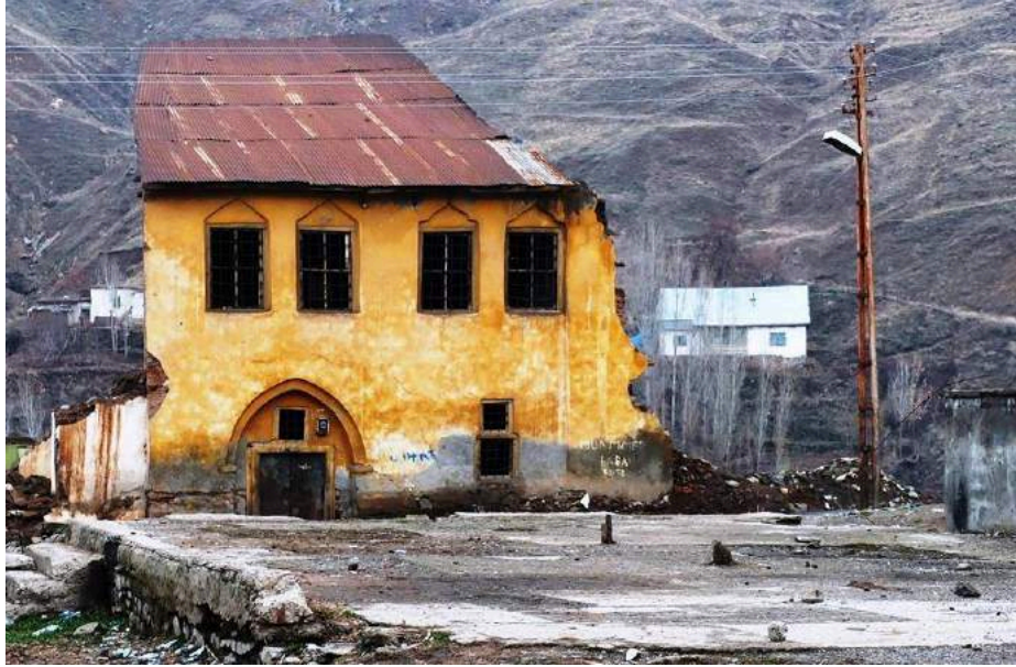
Şekil 4.6: Kale Mahallesi yıkım süresinde bir kısmı yıkılan geleneksel konut (Kapan, 2013)
