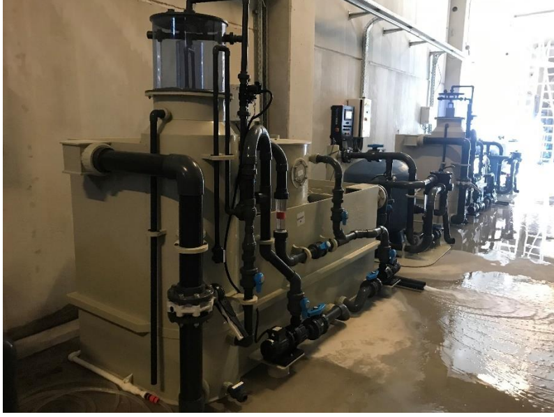
Şekil.2.4 Kuluçkahane filtrasyon ekipmanları (orginal)
