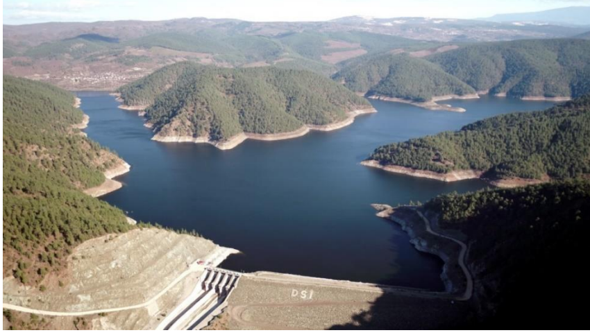
Şekil 3.1.4 Çınarcık Barajı (Anonim, 2022)
