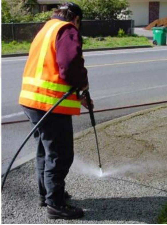
Şekil 2.8 Basınçlı su ile tıkanmayı açma (Tong, 2011).
