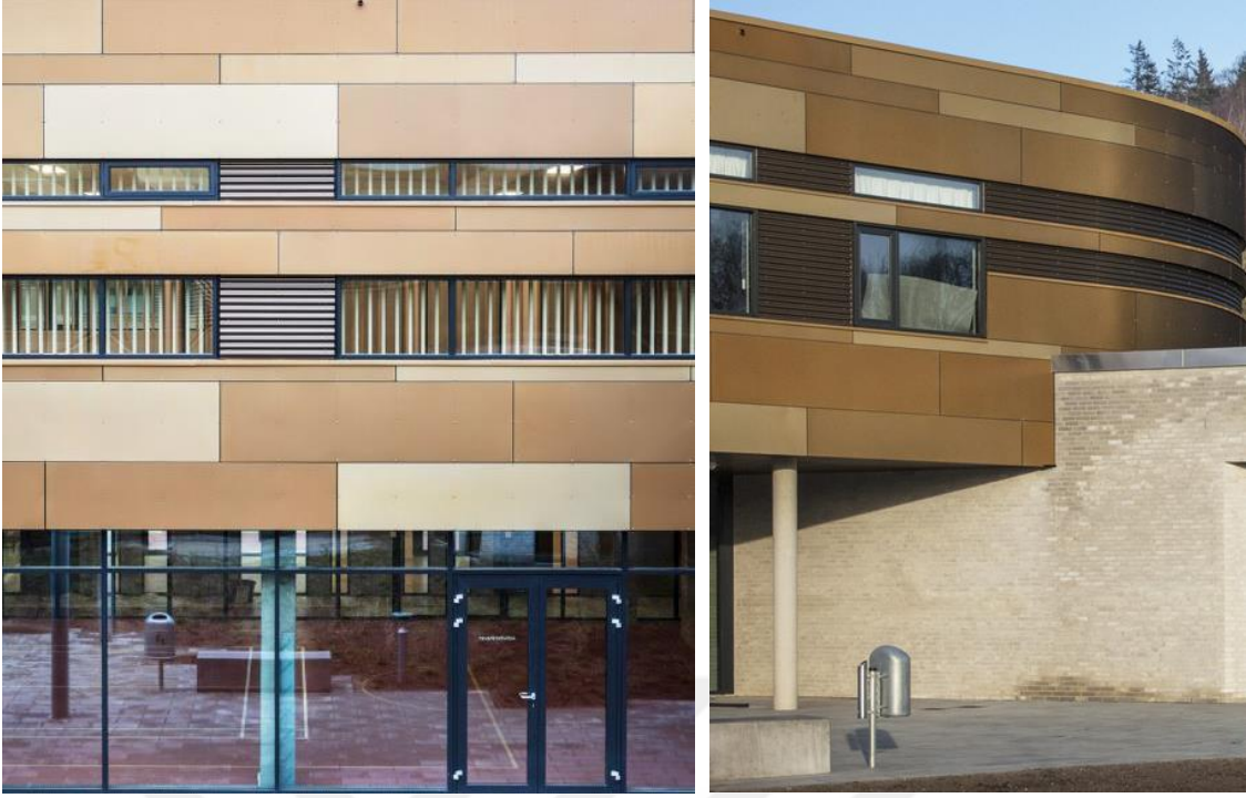
Görsel 73-74: Vejle Psikiyatri Hastanesi Dış Cephe Malzeme Kullanımı (URL 58-59).
