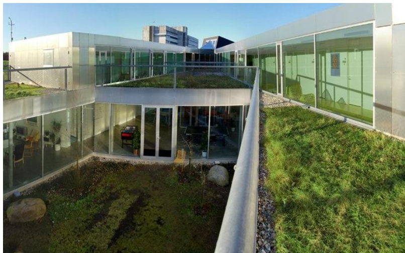
Görsel 46: Helsingør Psikiyatri Hastanesi Farklı Kotlarda Bahçe Alanları (URL 40).
