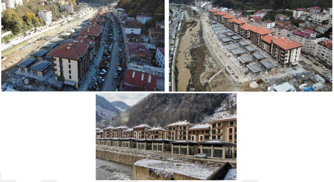
Şekil 22. Taşkıdan sonra yeniden inşa edilen Dereli ilçesi (URL-12)
