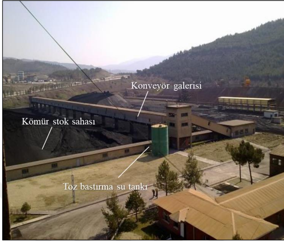
Şekil 2.9. Kömür Hazırlama Tesisi.
