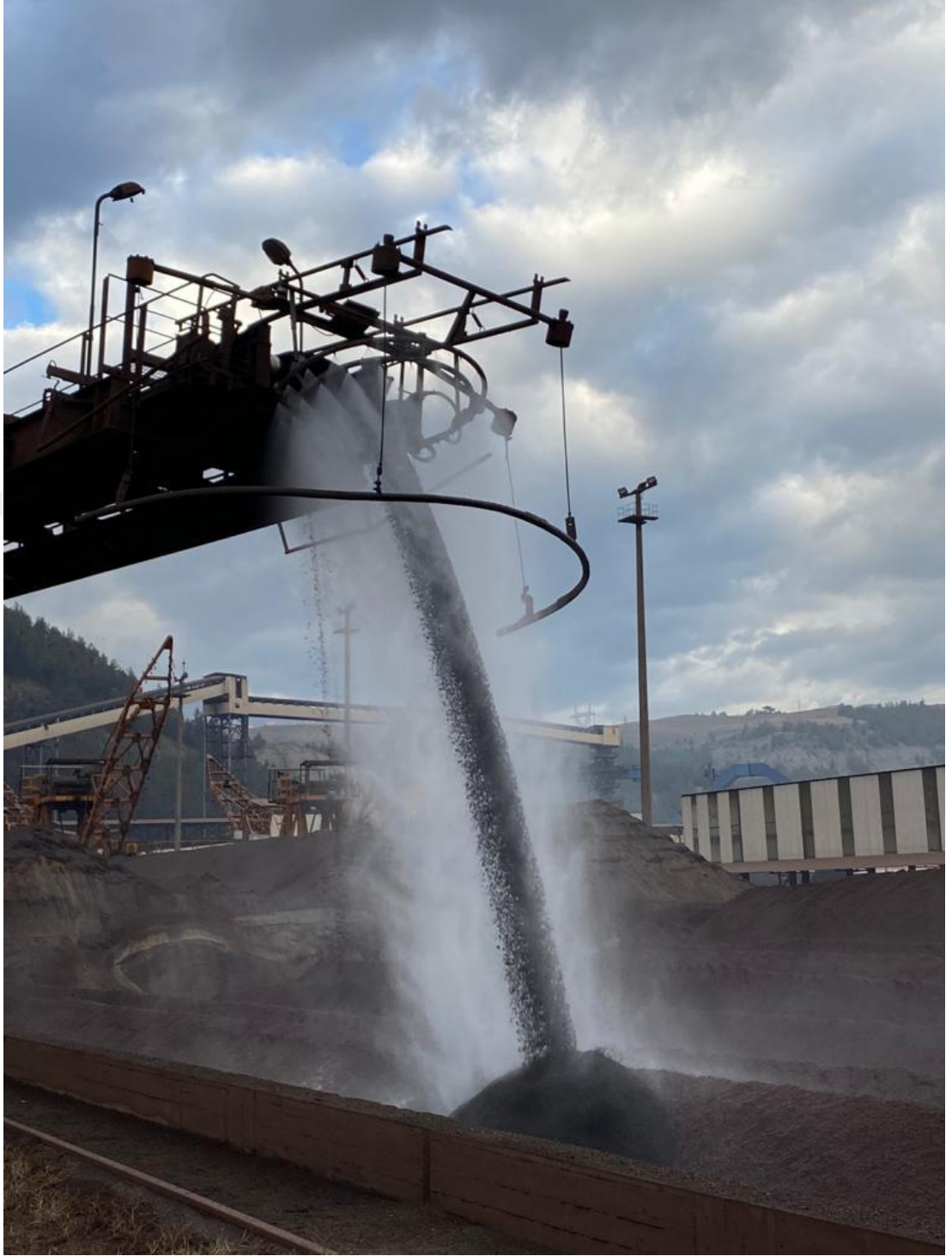
Şekil 2.25. Kardemir’de Halka ring uygulaması ile toz bastırma.
