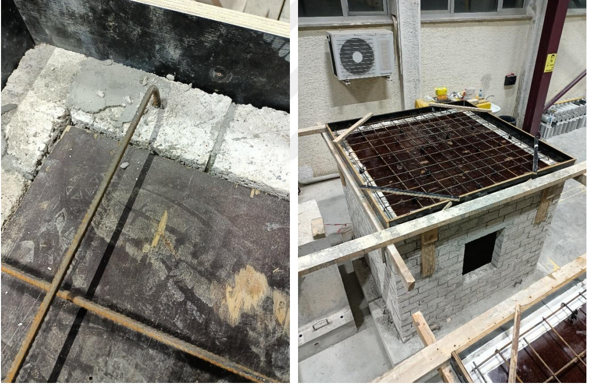
Şekil 2.80. Döşeme donatı çalışması
