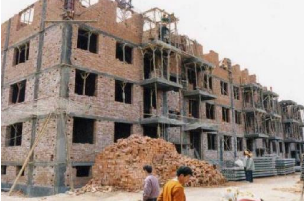
Şekil 1.4. Sarılmış yığma duvar örneği [72].
