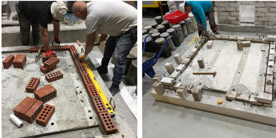
Şekil 2.7. İlk duvar birimlerin temele gömülmesi
