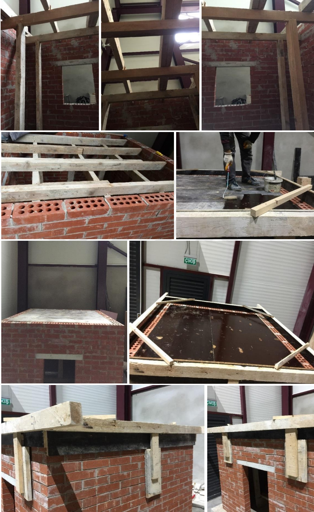
Şekil 2.10. Döşeme kalıp üretimi
