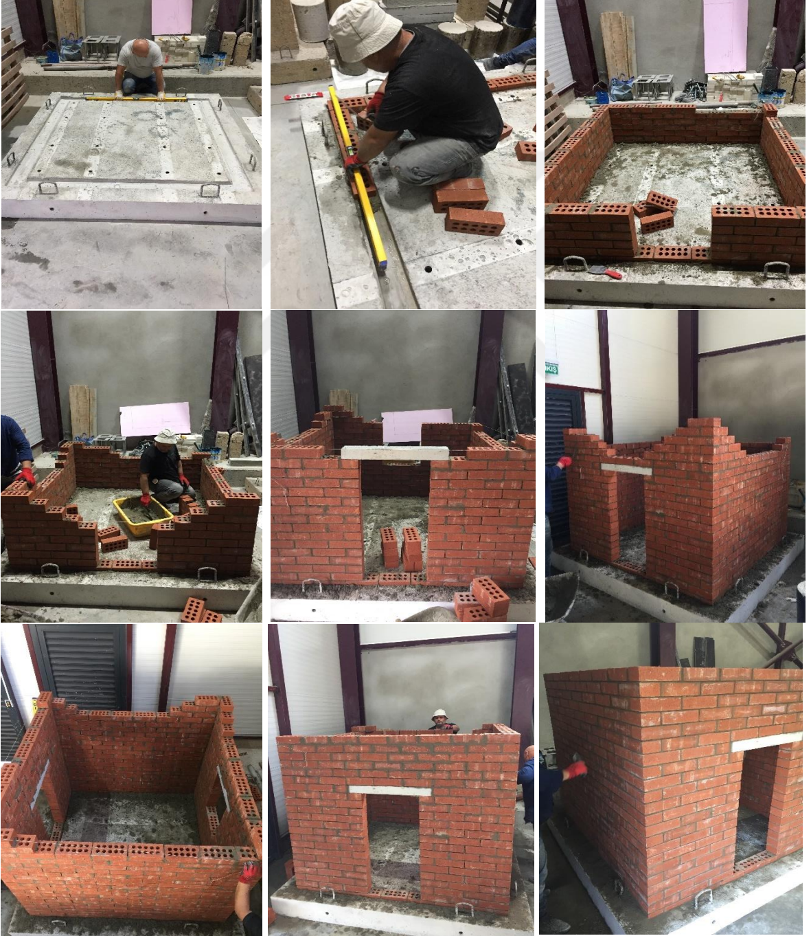
Şekil 2.9. Delikli tuğla duvar örümü
