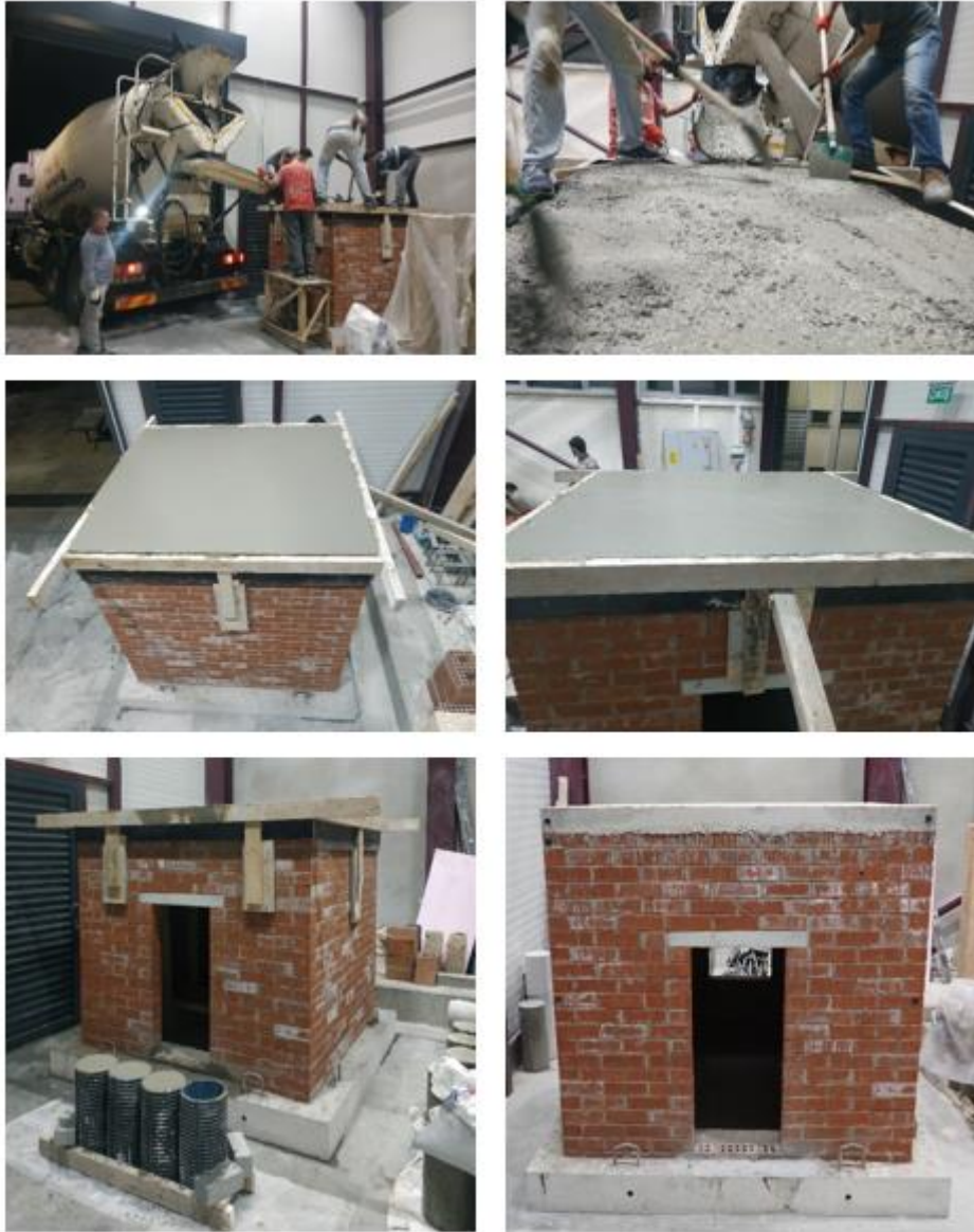
Şekil 2.12. Ön deney model döşeme beton dökümü ve inşası tamamlanmış model
