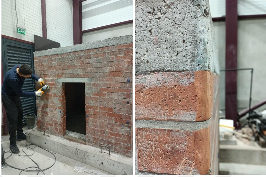
(a) Yüzeyin temizlenmesi ve köşelerin ovalleştirilmesi
