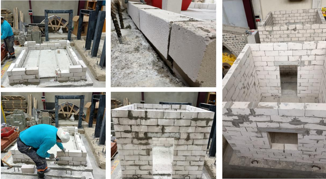
Şekil 2.100. Gaz beton duvar üretimi
