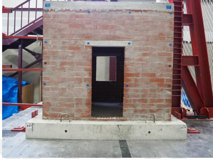
Şekil 2.41 İnşası tamamlanmış tuğla model
