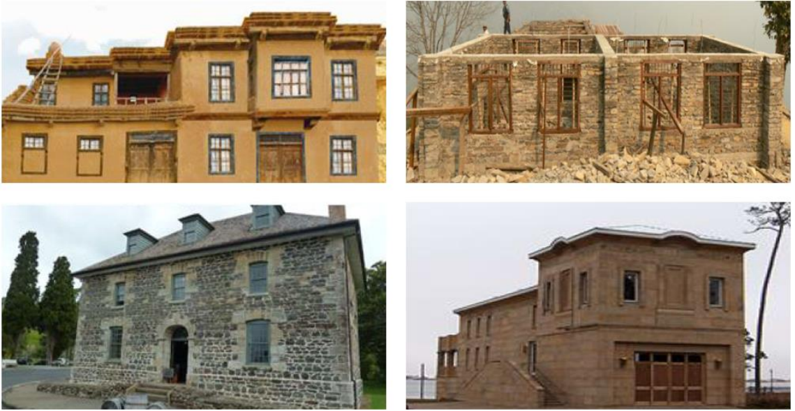
Şekil 1.2. Donatısız yığma yapılar [71].
