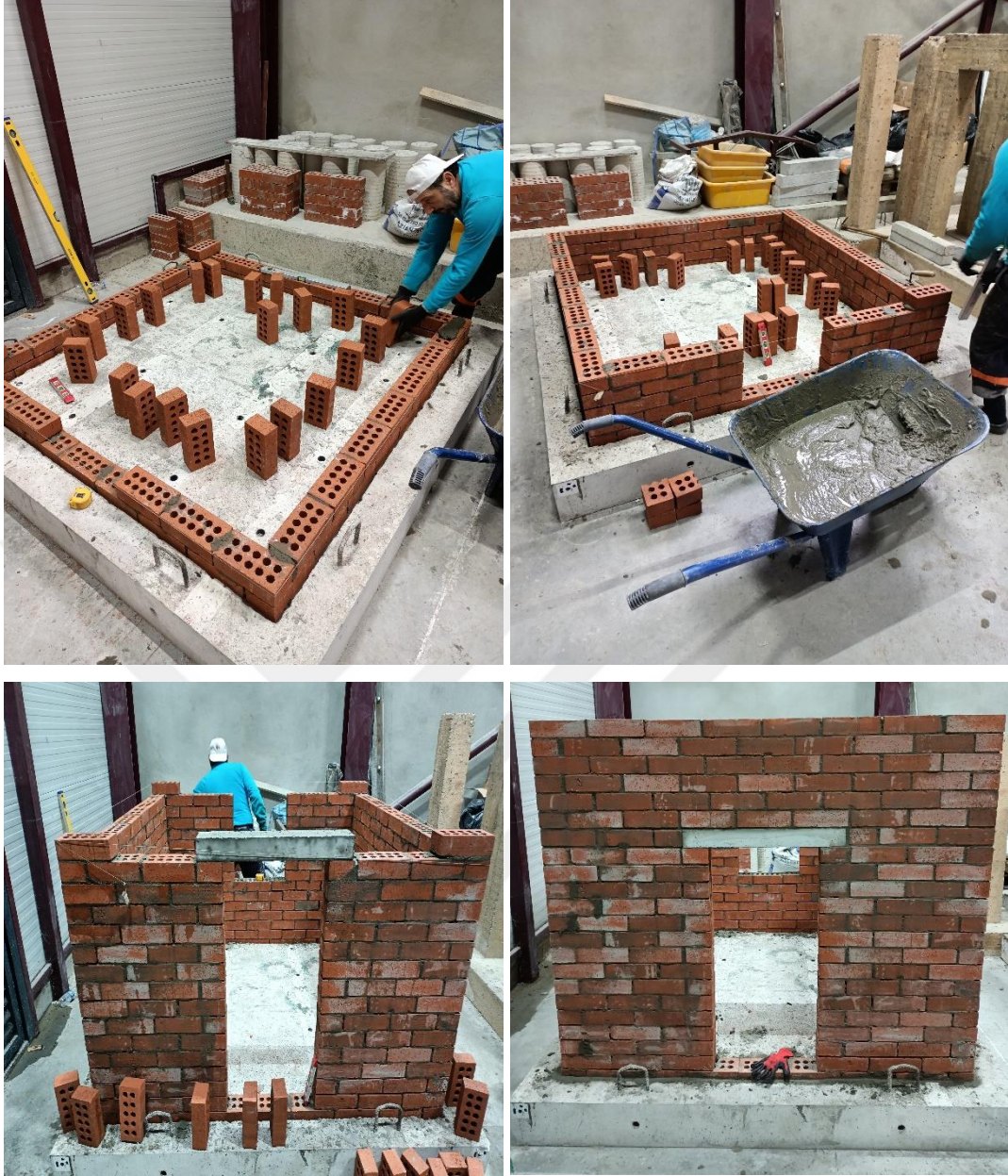
Şekil 2.40. Delikli tuğla duvar üretimi
