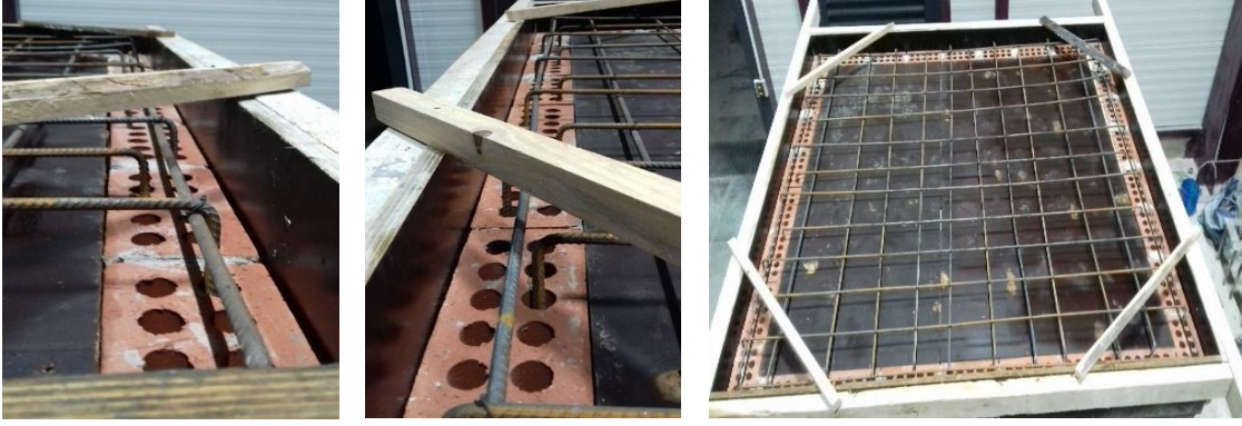
Şekil 2.11. Döşeme donatı uygulaması
