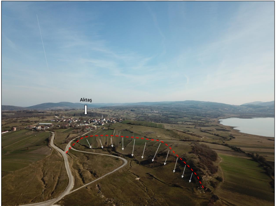
Şekil 4.19. Araştırma sahası heyelan örnekleri (Aktaş Mahallesi batısı).
