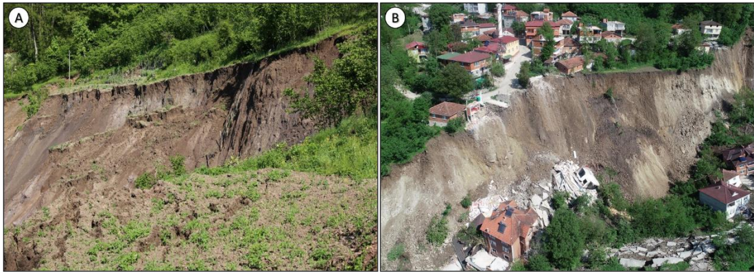
Şekil 1.2. Bir heyelanın tehlike (A) ve doğal afet durumundaki görünümü (B), (URL-3;4).
