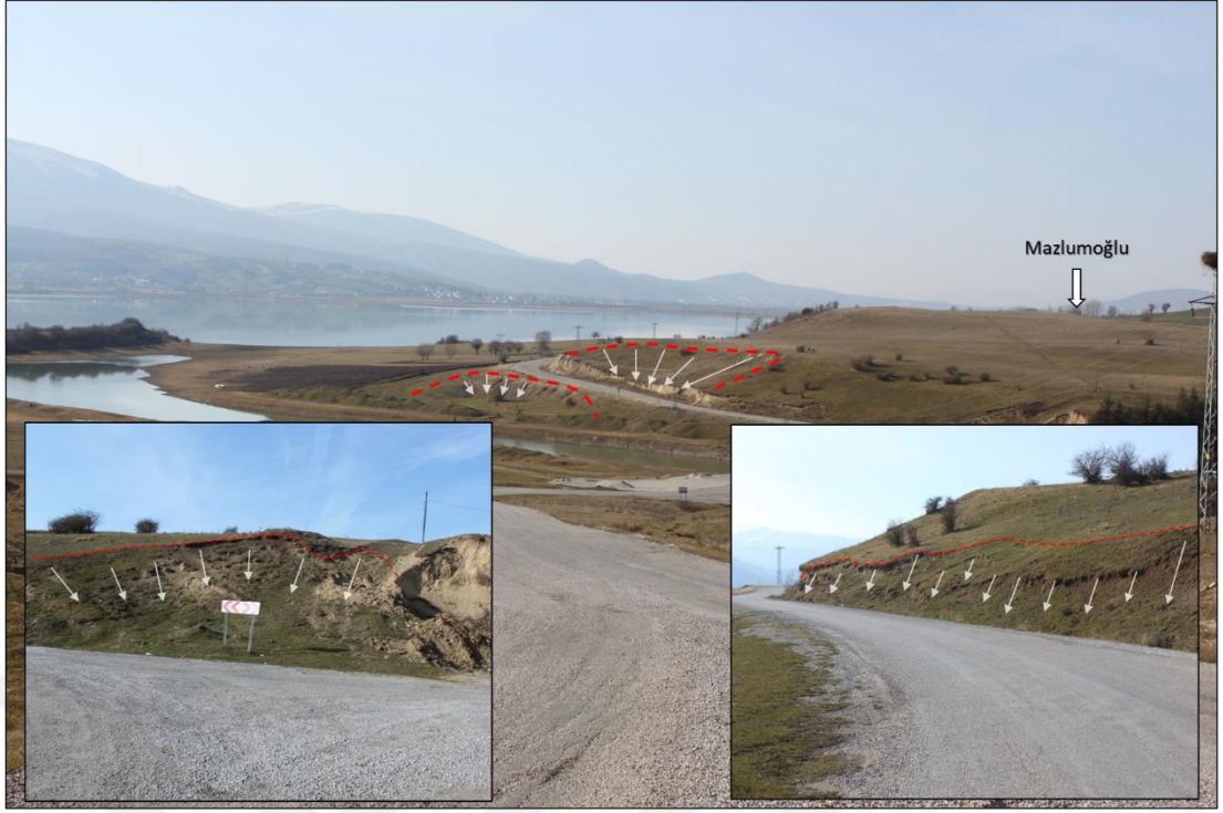
Şekil 4.18. Araştırma sahası heyelan örnekleri (Mazlumoğlu Mahallesi doğusu).
