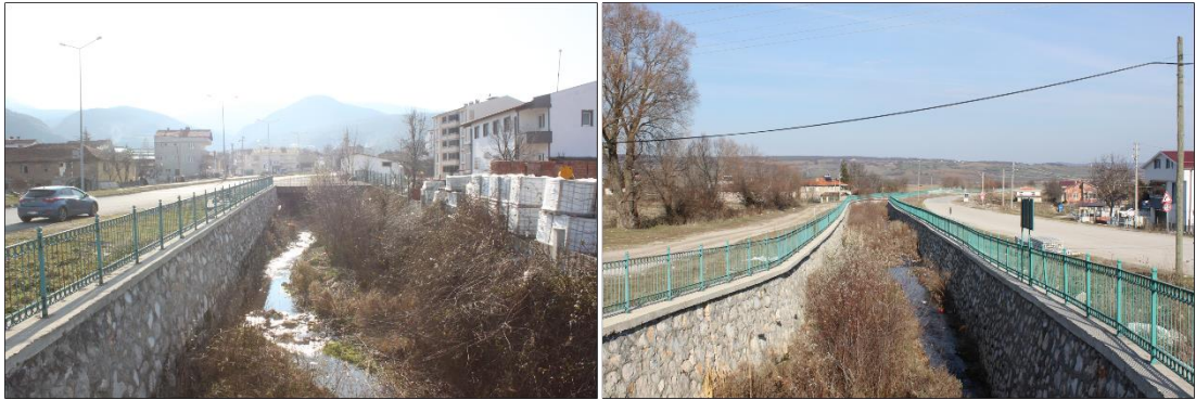
Şekil 4.10. İlçe merkezinden geçen Değirmen Dere'deki evsel atık ve oluşan sazlıklar.
