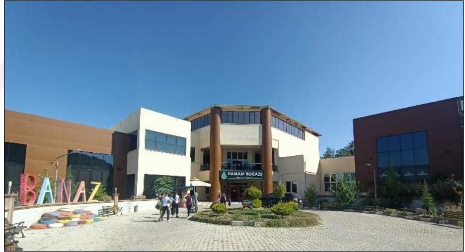
Görsel 38: Hamamboğazı Termal Tesisleri (Foto: F. Yakın)
