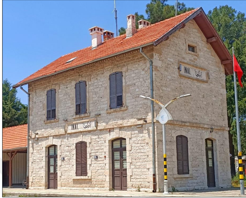
Görsel 24: İnay İstasyonu (Foto: F. Yakın).
