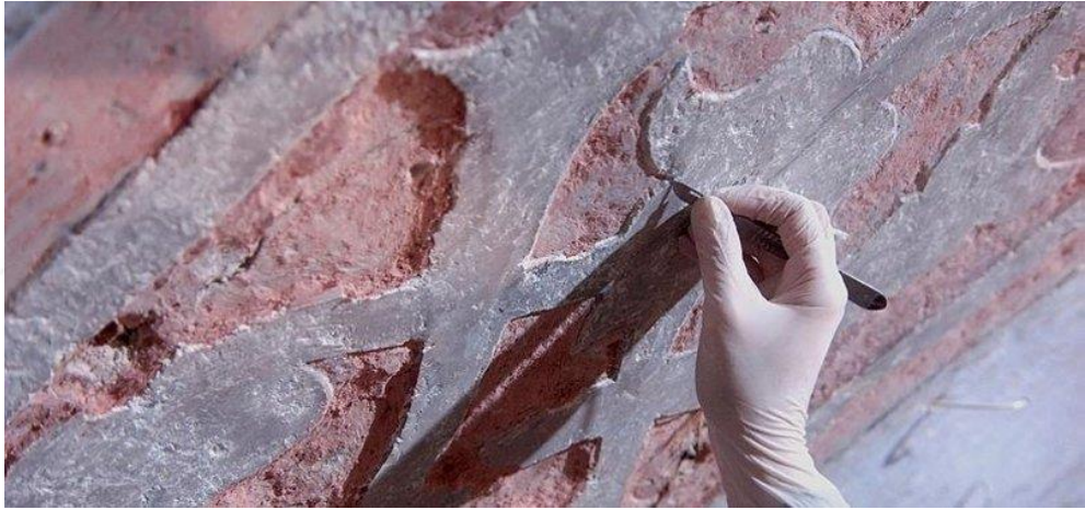
Şekil 4.20. Taş malzemenin temizlenmesi
