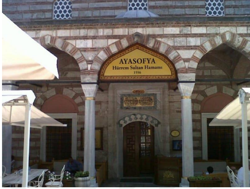
Şekil 5.7. İstanbul'da bulunan Hürrem Sultan Hamamı, Horasan harcı ile yapılmıştır
