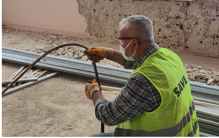
Şekil 4.14. Kimyasallar ile zemin stabilizasyonu ve güçlendirme
