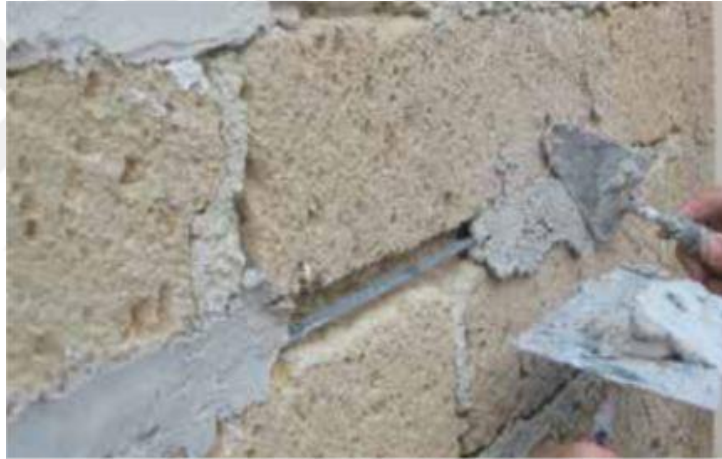
Şekil 4.11. Karbon lifli fiber çubuk ile duvar derzinde yapılan güçlendirme uygulaması
