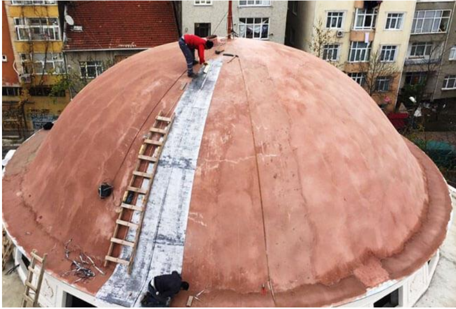
řekil 5.8. Horasan harcının uygulanması
