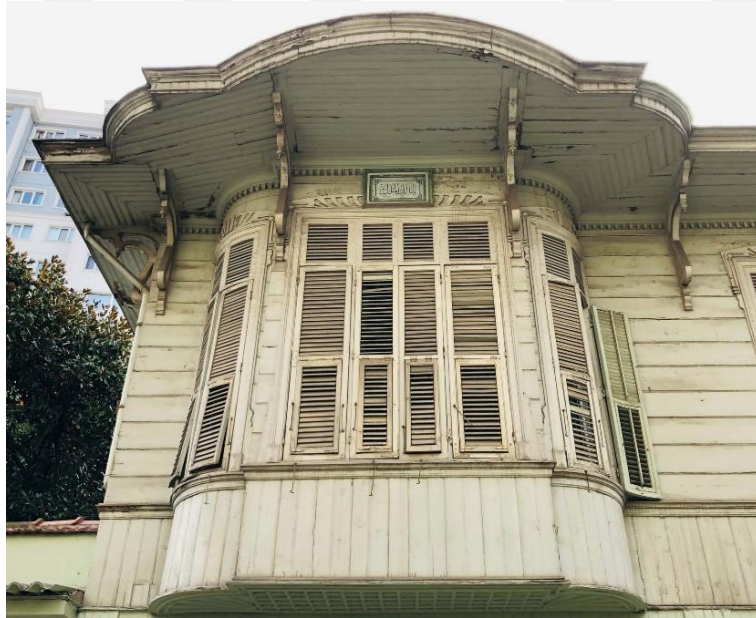
Şekil 5.10. İstanbul Erenköy’de bulunan Kabasakal Mehmet Paşa (Gezeryan) Köşkü ahşap cephe, pencere ve payanda
