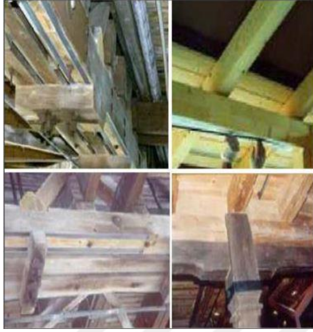
Şekil 4.8. Ahşap elemanların fiber takviyeli polimerler ile sağlamlaştırılması
