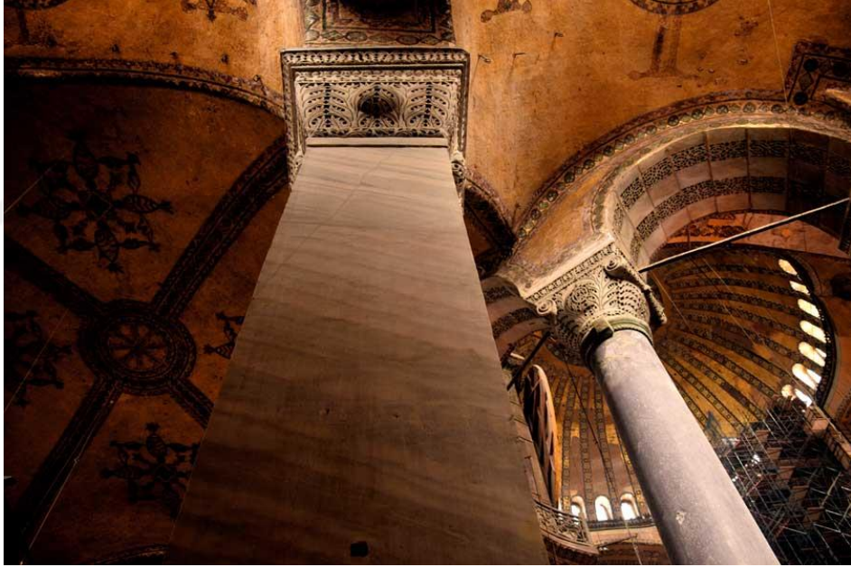
Şekil 4.6. Ayasofya Restorasyon, Sütun Başı Sağlamlaştırma Çalışmaları
