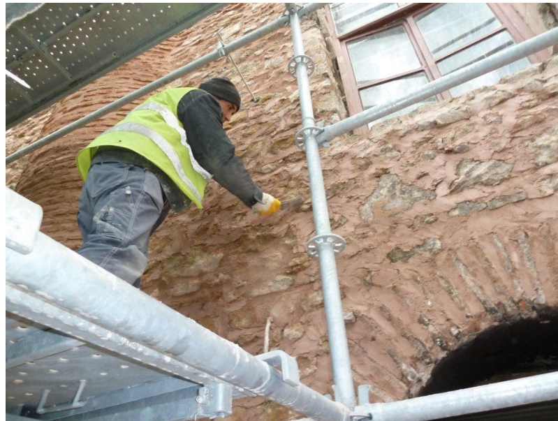
Şekil 5.6. Kireç harcının derz ve sıva işlemlerinde uygulanması
