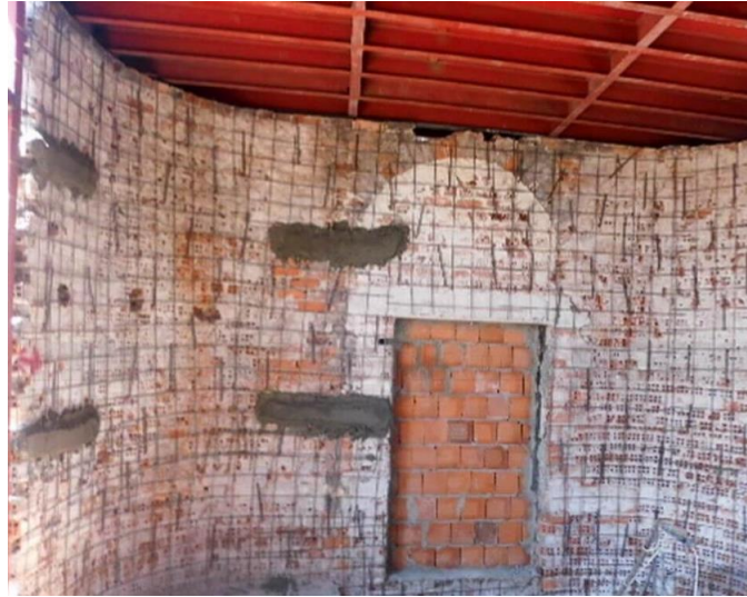
Şekil 4.12. Yığma kargir binalara püskürtme beton ile taşıyıcının güçlendirilmesi
