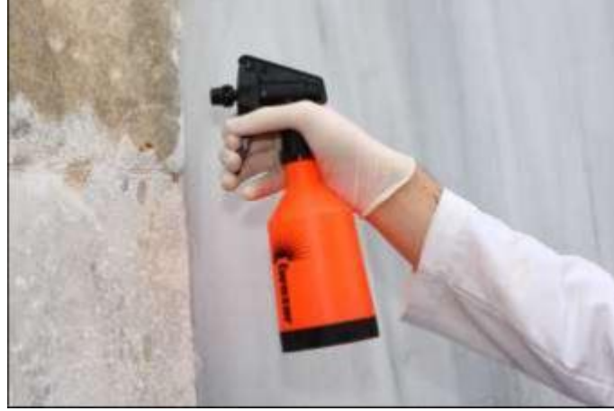
Şekil 4.9. Püskürtme yöntemiyle sağlamlaştırıcı ve su itici uygulanması
