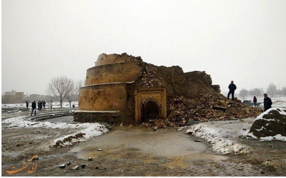
Şekil 6.6. İran Lorestan eyaletinde bulunan Keşkan Köprüsü, sel sonrası
