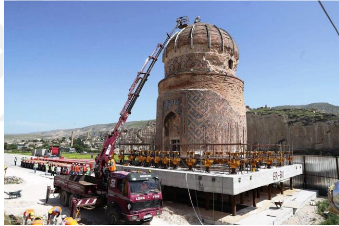
Şekil 4.21. Ilısu Baraj gölü altında kalacak olan tarihi Hasankeyf ilçesindeki Zeynel Bey Türbesi'nin raylı sistemlerle taşınması
