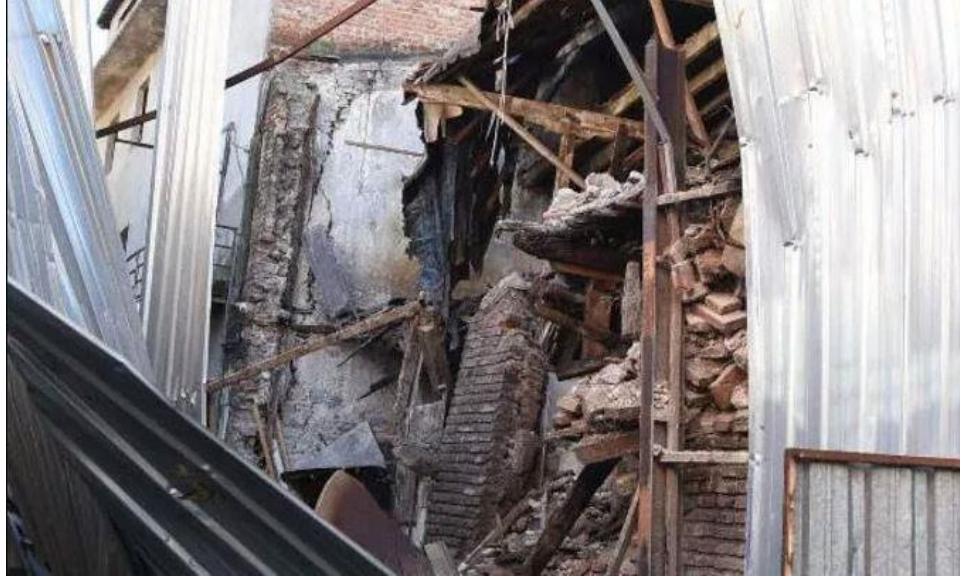
Şekil 6.4. İzmir Tarihi Kemeraltı Çarşısı'nda tarihi binada taşıyıcı sistemin hasarı
