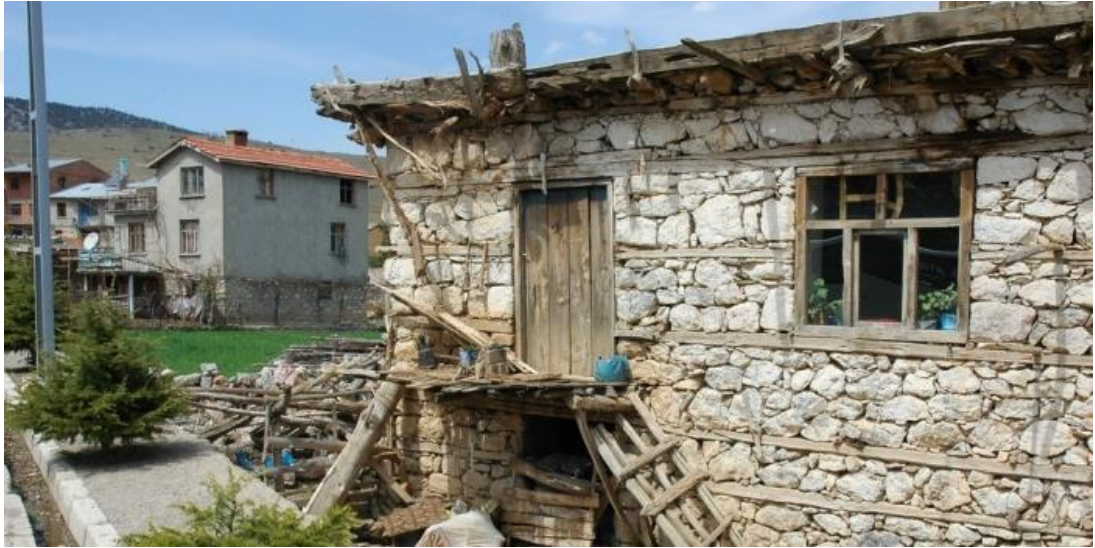
Şekil 5.9. Ülkemizde kargir malzeme ile yapılmış yapı örneği
