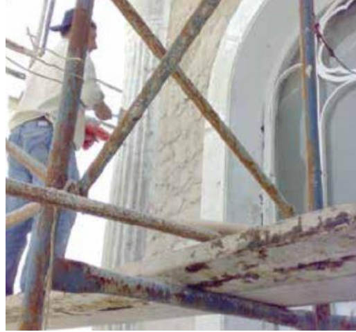
Şekil 4.10. Yığma duvarda sıva güçlendirmesi yapılması
