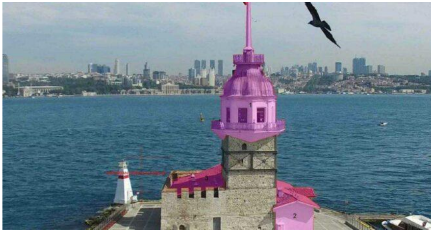
Şekil 4.16. Kız Kulesi Restorasyon çalışmalarında 1 ve 2 numaralı 1940 onarımında betonarmeye çevrildiği için sökülen kısımlar ahşap yenilenmesi
