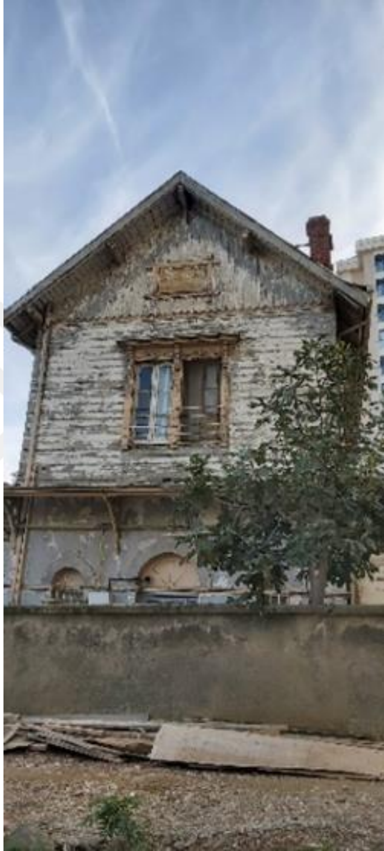
Fotoğraf A.5. Göztepe İstasyon Lojmanı Kuzeybatı Cephe görünüş, 2021
