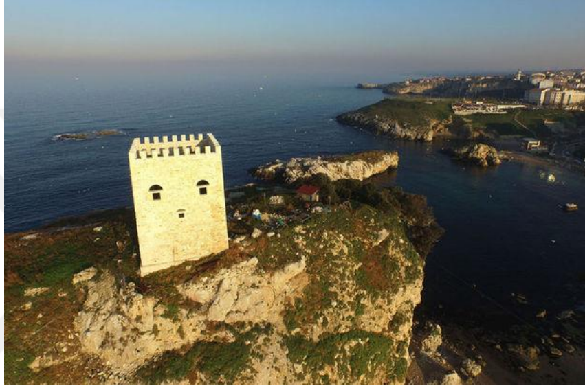
Şekil 6.5. Şile Kalesi restorasyon çalışmaları sonrası
