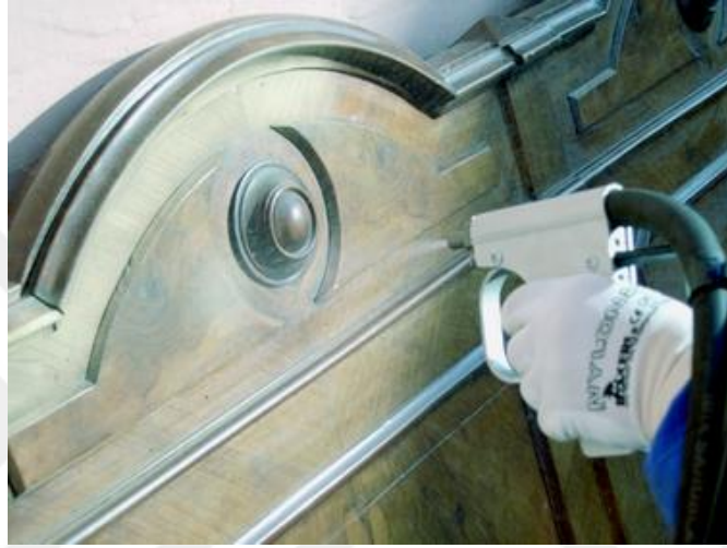
Şekil 4.19. Ahşap malzemenin temizlenmesi
