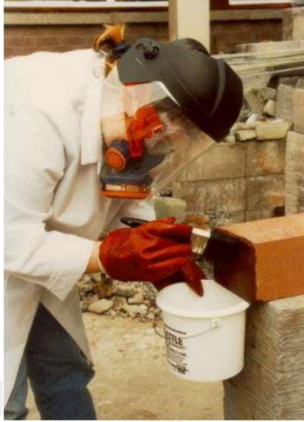
Şekil 4.7. Fırçayla sürme yöntemiyle sağlamlaştırıcı ve su itici uygulanması
