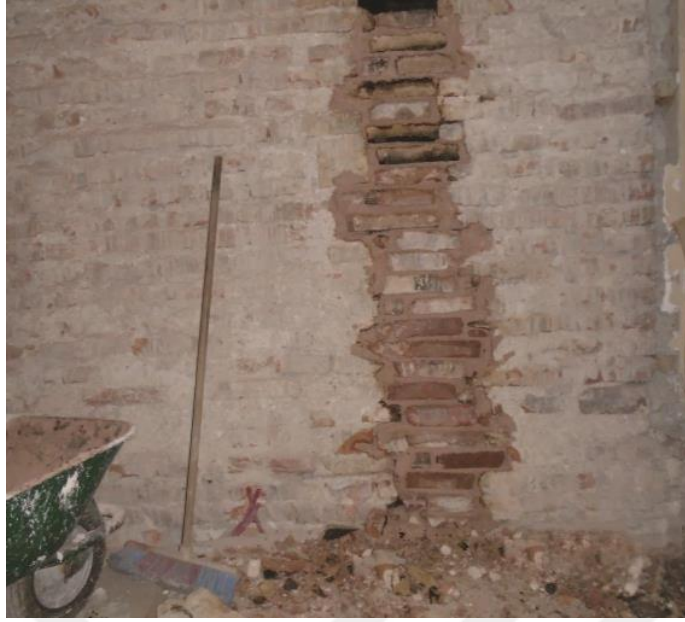
Şekil 14. Fener Rum Patrikhanesi Katolik Kilisesi ( E Blok ) Dikiş Kenet Uygulaması
