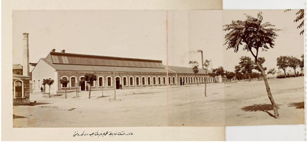
Şekil 90. Uzun Bina (Fişekhane) (Batı Cephe)
