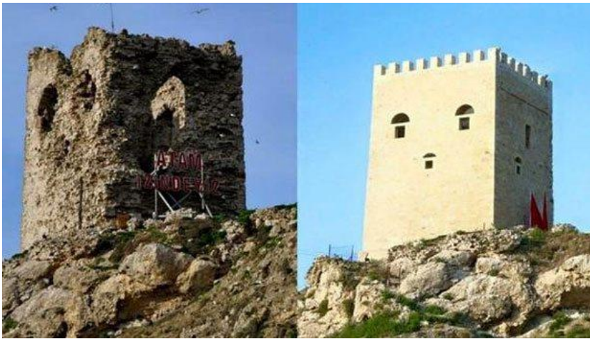
Şekil 21. Şile Kalesi Restorasyon Öncesi ve Sonrası Yenileme Örneği
