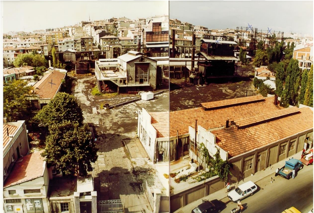
Şekil 74. Hasanpaşa Gazhane Restorasyon Projesi Öncesi
