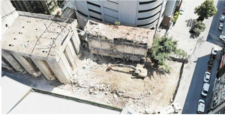
Şekil 129. Yıkımı Gerçekleştirilen Ek Yapılar
