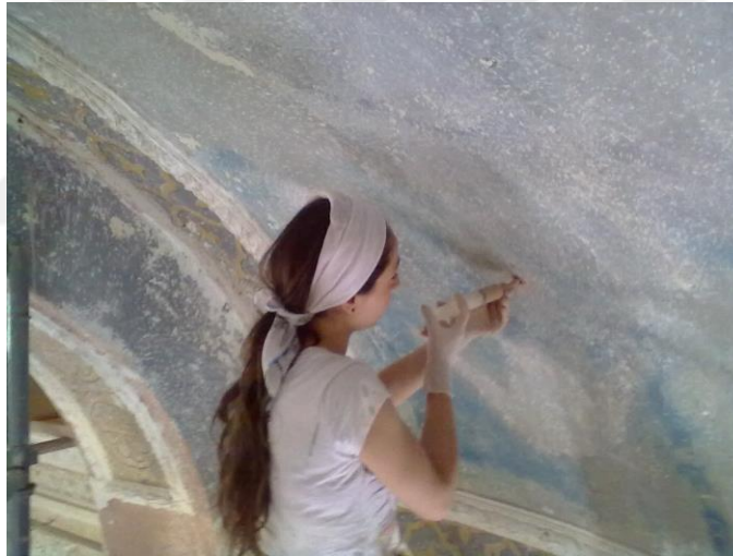
Şekil 15. Eglisia Notre Dame Du Rosarie Katolik Kilisesi Mikro Enjeksiyon Uygulaması
