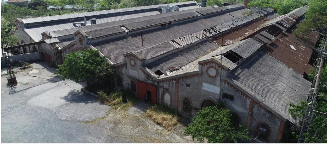
Şekil 35. Küçükçekmece Kibrit Fabrikası
