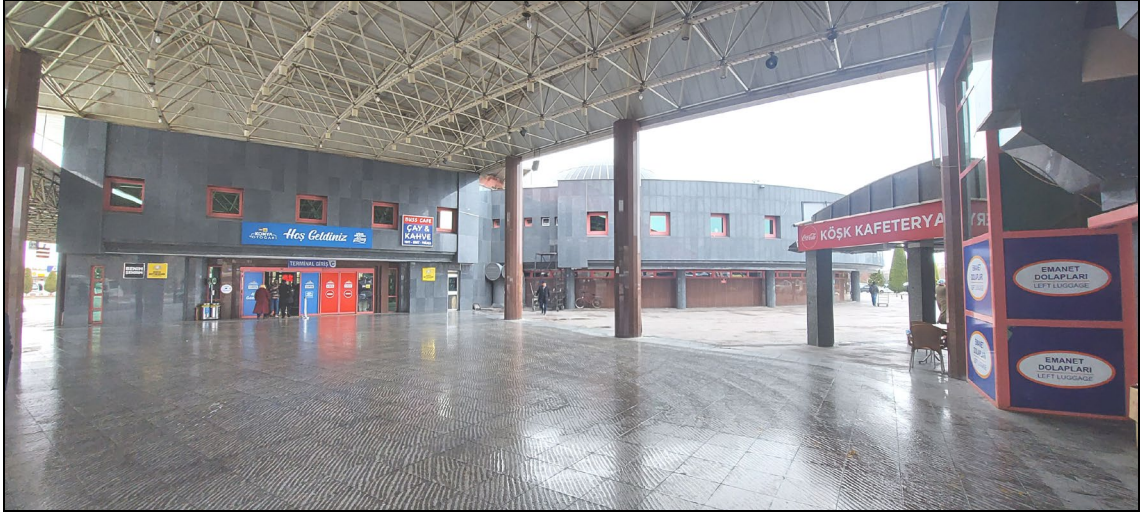
Şekil 4.44. Konya Otogar Batı Cephesi (Yazar Arşivi)
