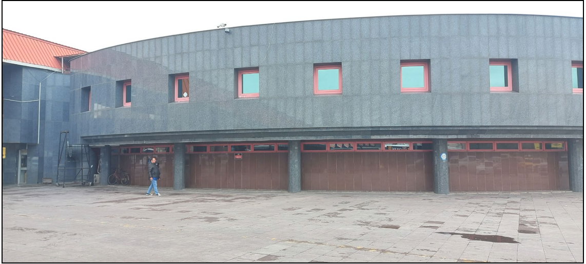
Şekil 4.43. Konya Otogarı Güney Cephesi (Yazar Arşivi)
