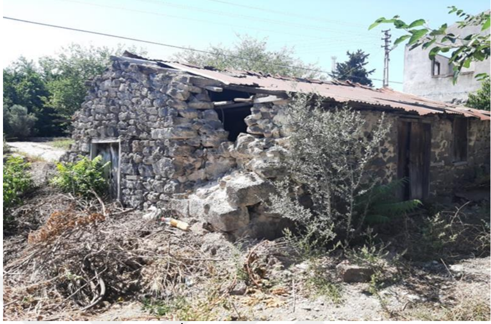
Ek-1.9. İskân Evi Cepheden Görünümü.
