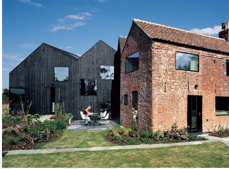
Şekil 8. Hunsett Mill Değirmeni ( https://divisare.com )
