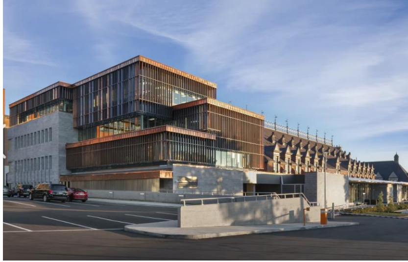
Şekil 12. Voltigeurs De Québec Cephaneliği yeni ek binası ( https://architizer.com )
