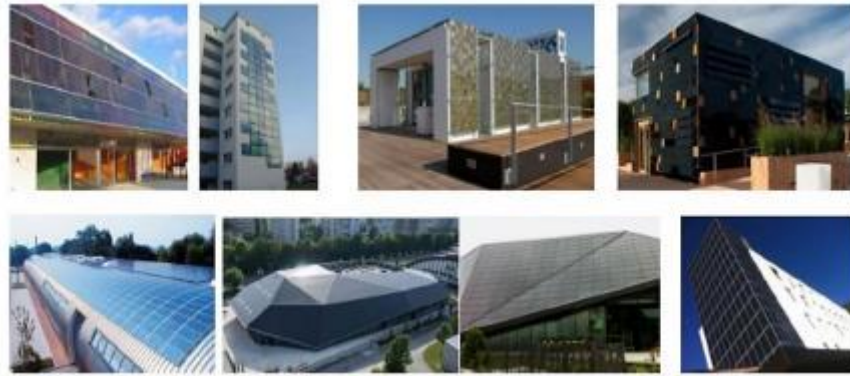
Şekil 4. 13. Bina kabuğuna uygulanmış Fotovoltaik panel uygulamaları (Yılmaz vd., 2015).
