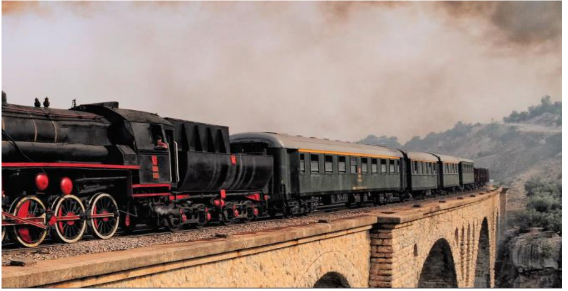
Şekil 1.4. Viyadük üzerinde kara tren
