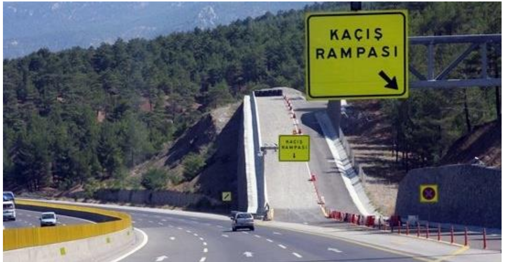
Şekil 1.3. Pozantı Tarsus arasında bulunan kaçış rampası
