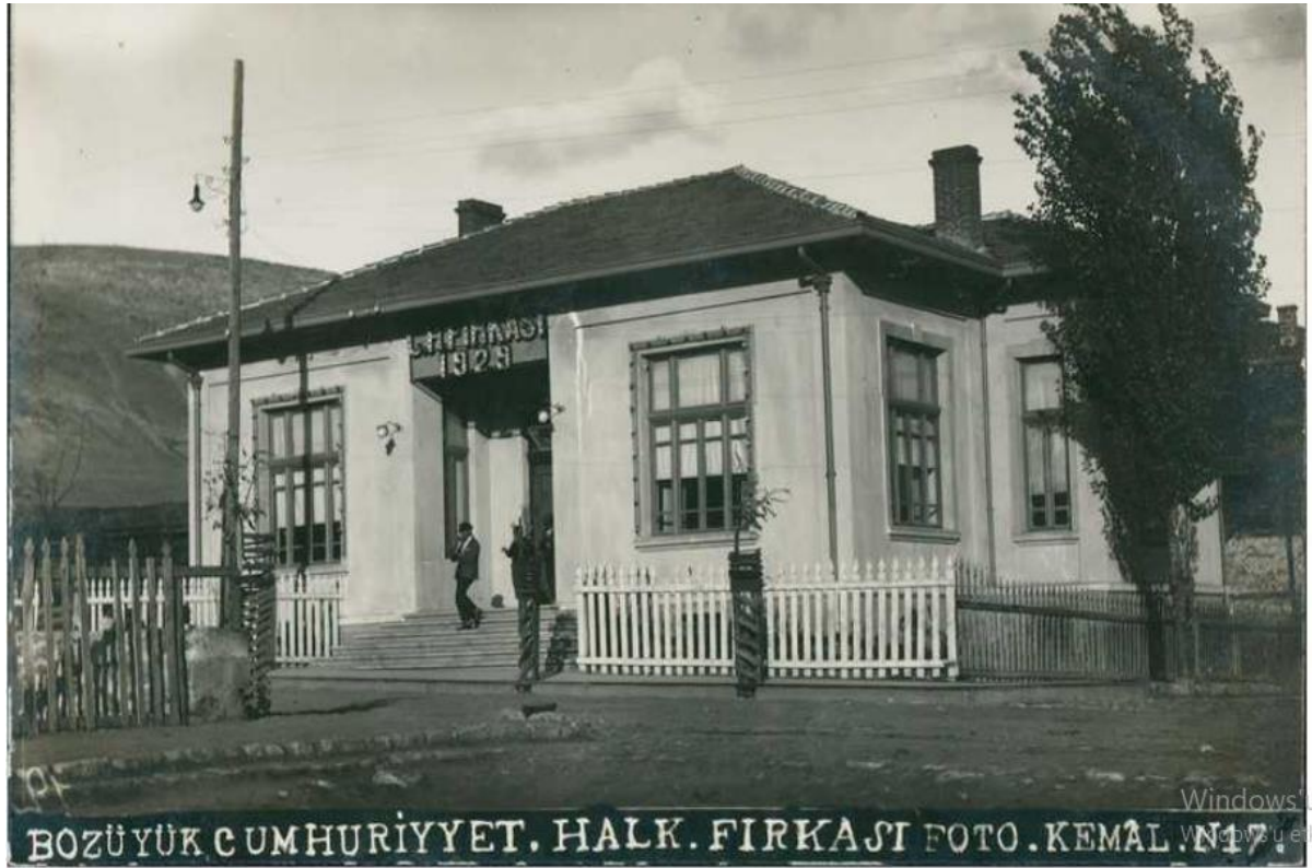
Ek 6: Bozüyük CHF Binası
