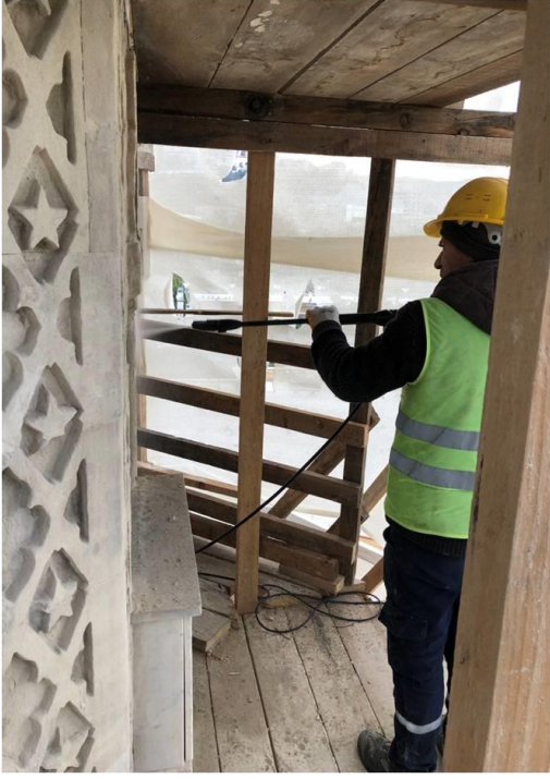
Şekil 5. Mikro hassas kumlama
