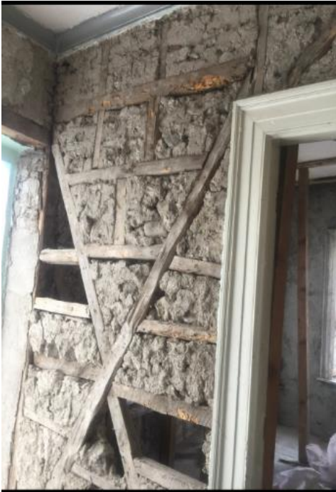
Şekil 12. Ahşap Karkaslı Taş Dolgu Duvar ve Tavan göbekleri askıya alma
