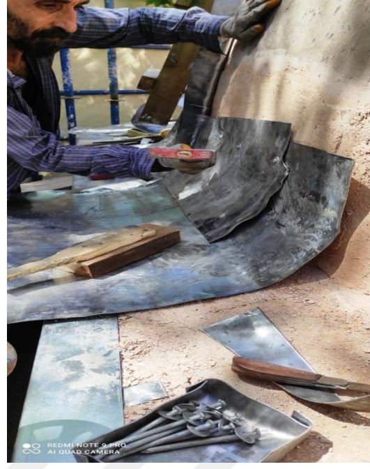
Şekil 7. Alem sökümü ve kurşun plaka yerleştirilmesi
