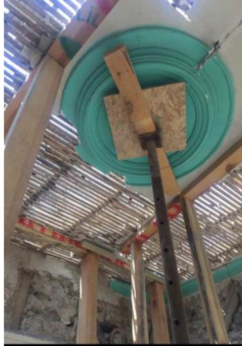
Şekil 12. Ahşap Karkaslı Taş Dolgu Duvar ve Tavan göbekleri askıya alma
