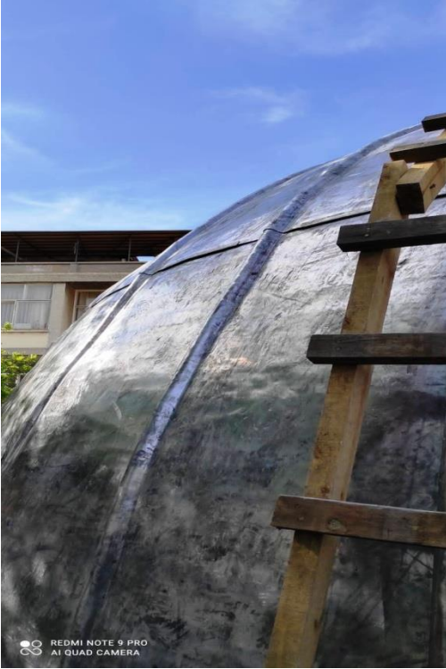
Şekil 8. Kurşun kaplaması ve sütun temizliği
