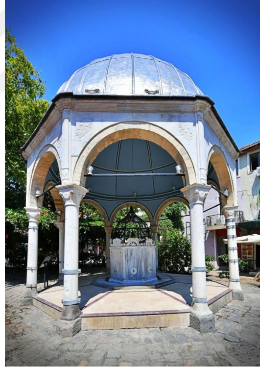
Şekil 8. Kurşun kaplaması ve sütun temizliği
