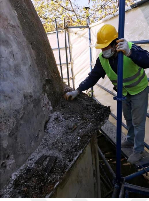
Şekil 7. Alem sökümü ve kurşun plaka yerleştirilmesi
