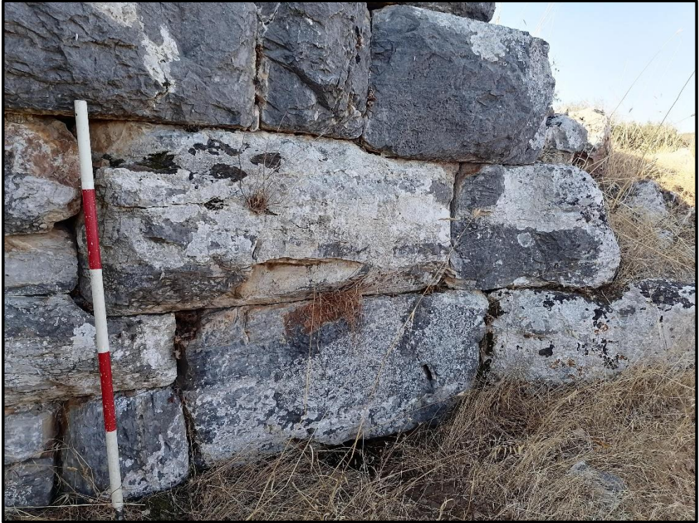
Resim 36: Panayır Dağı kuzey bölümü, Roma Çağı sur duvarlarının Helenistik Dönem zemin seviyesinden detay.
