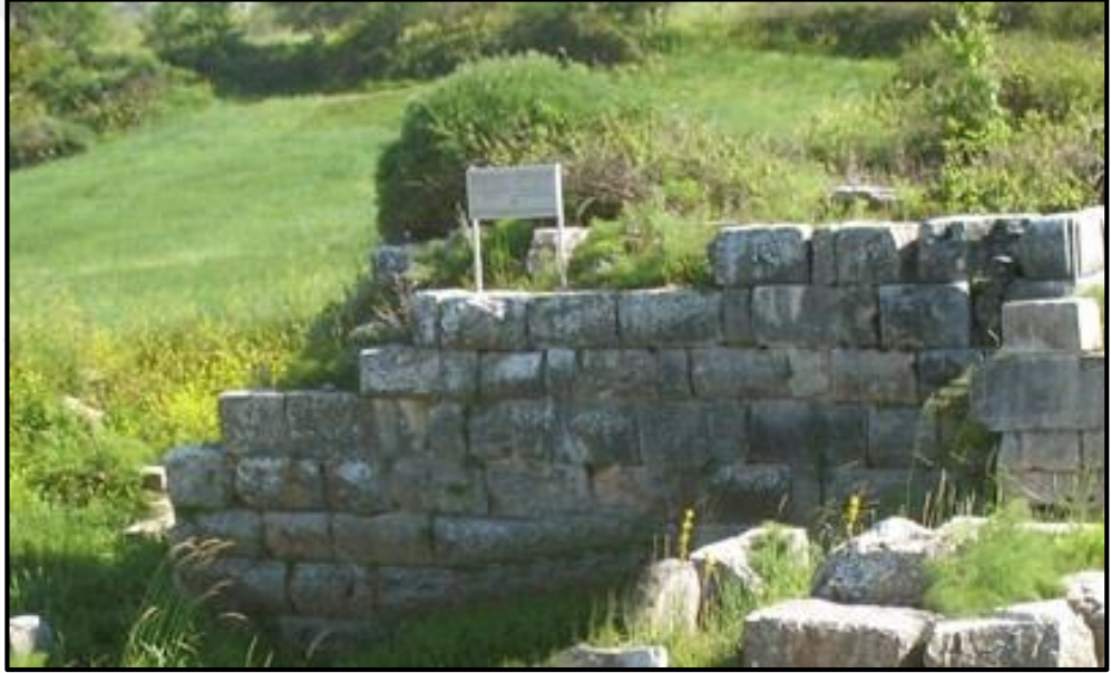
Resim 86: Magnesia Kapısı'nın güney kule yan cephe örgü detayı.
