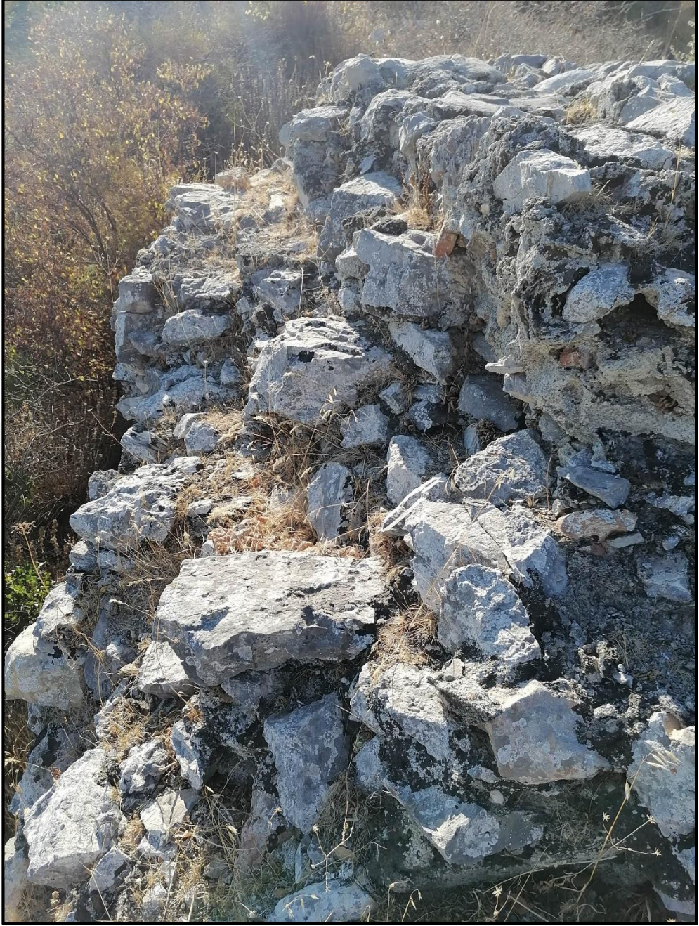
Resim 39: Helenistik D nem sur duvarlarının deprem etkisi ile dolgu aralarının Roma D nemi'nde beyaz kire  harcı ve ta  par aları ile doldurulduėu Panayır Daėı kuzey b l m  surlarından detay.
