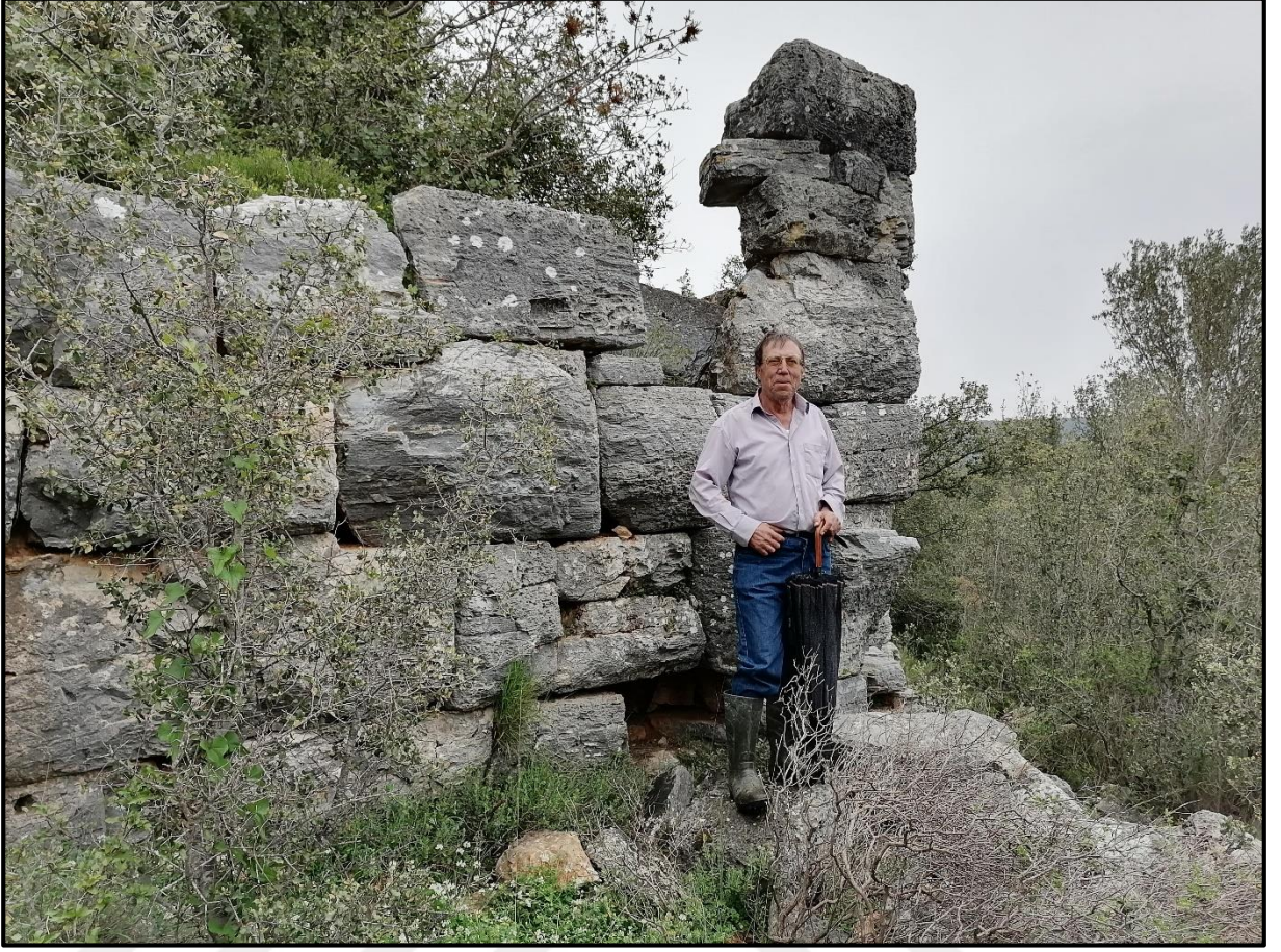
Resim 29: Barutçu Kalesi sur duvarları bazı noktalarında 3 m. yüksekliğine kadar korunagelmiştir.
