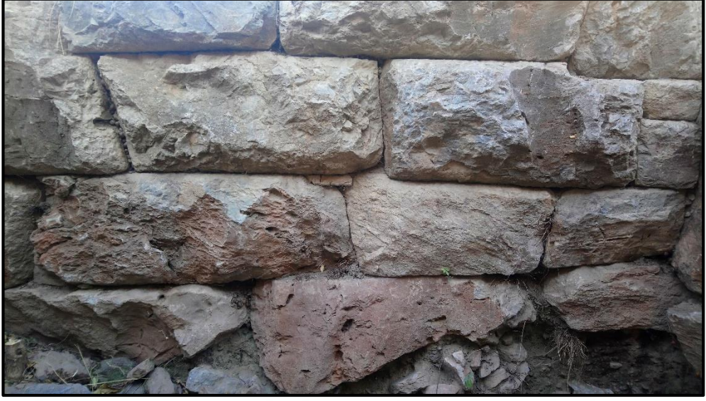
Resim 10: Ayasuluk Tepesi S23 Plankaresi sur duvarı örgü detayı.
