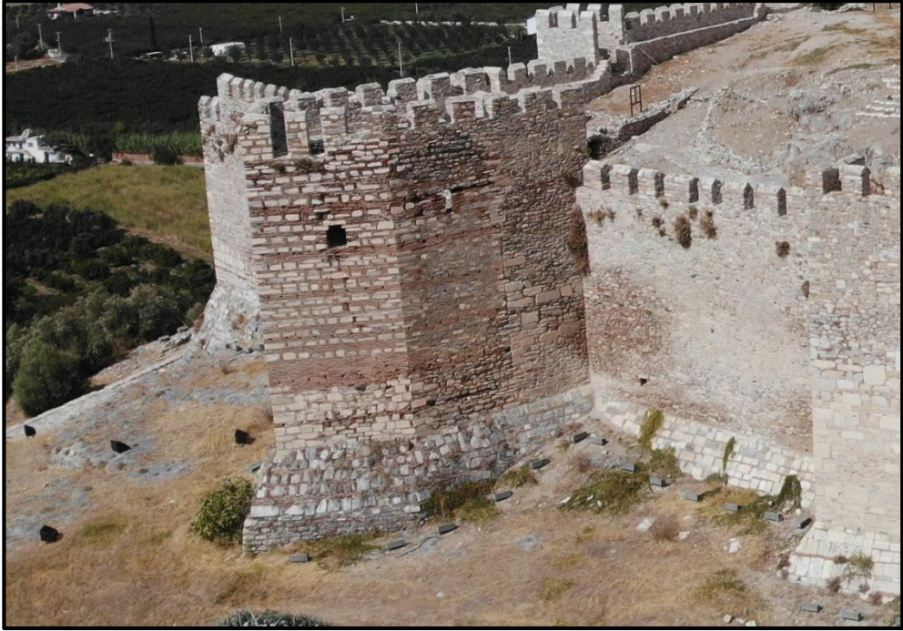
Resim 100: Ayasuluk tepesi iç kale doğu cephe M.S. XV. yy. evresi kare kule önüne ek yapılan beşgen formlu kule.
