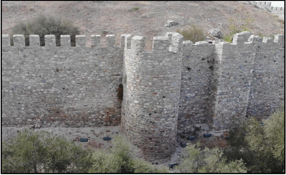
Resim 107: Ayasuluk iç kalesi doğu surları Beylikler dönemi yığma duvar daire formlu kule.
