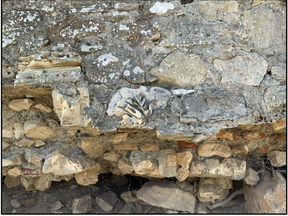
Resim 50: Ephesos Liman caddesi ile tiyatro birleşim noktası Roma Çağı surlarına geç dönem onarım evresi devşirme malzeme detayı.
