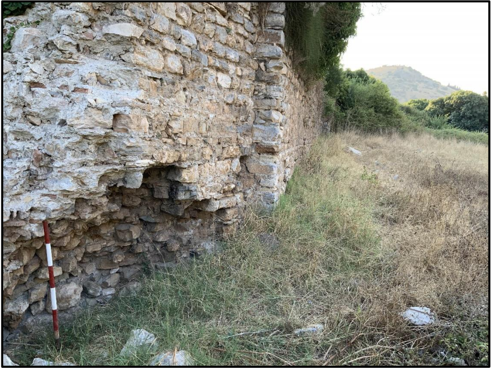
Resim 45: Ephesos Liman çevresi Roma Çağı güney kanat sur duvarları.
