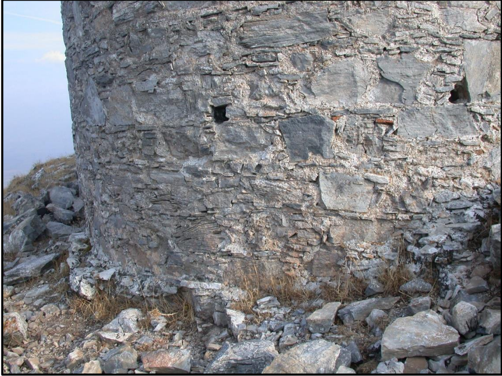
Resim 105: Keçi Kalesi daire formulu kule dış cephe örgü detayı görüntüsü (© E. Tok).
