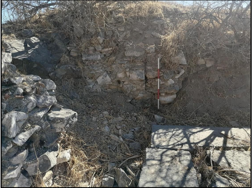
Resim 43: Ephesos Liman çevresi Roma Çağı kuzey kanat sur duvarları kaya tapınağı sınırlarından tapınak sınırlarına girmeden dik açı yaparak geçtiği doğu köşe görüntüsü.
