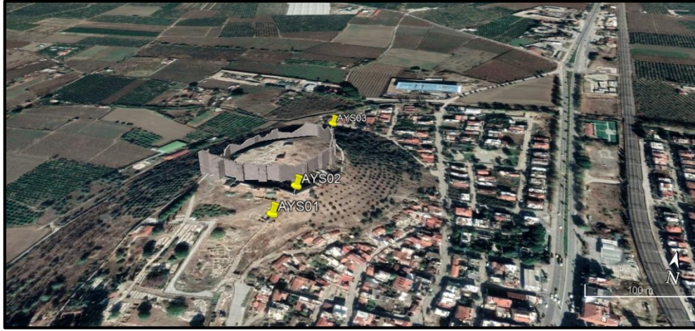
Resim 154a: Ayasuluk Tepesi'nde numune noktalarının uydu görüntüsü (Güneyden Kuzeye Sırasıyla AYS01-AYS02-AYS03)
