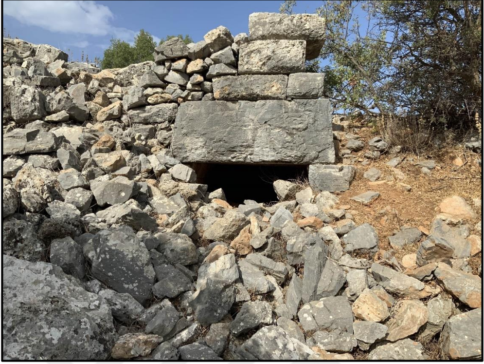
Res. 120: B lb l Dađı dođu surları b l m  d z s ve ve lentolu kare fomlu kule kapısı tipi.
