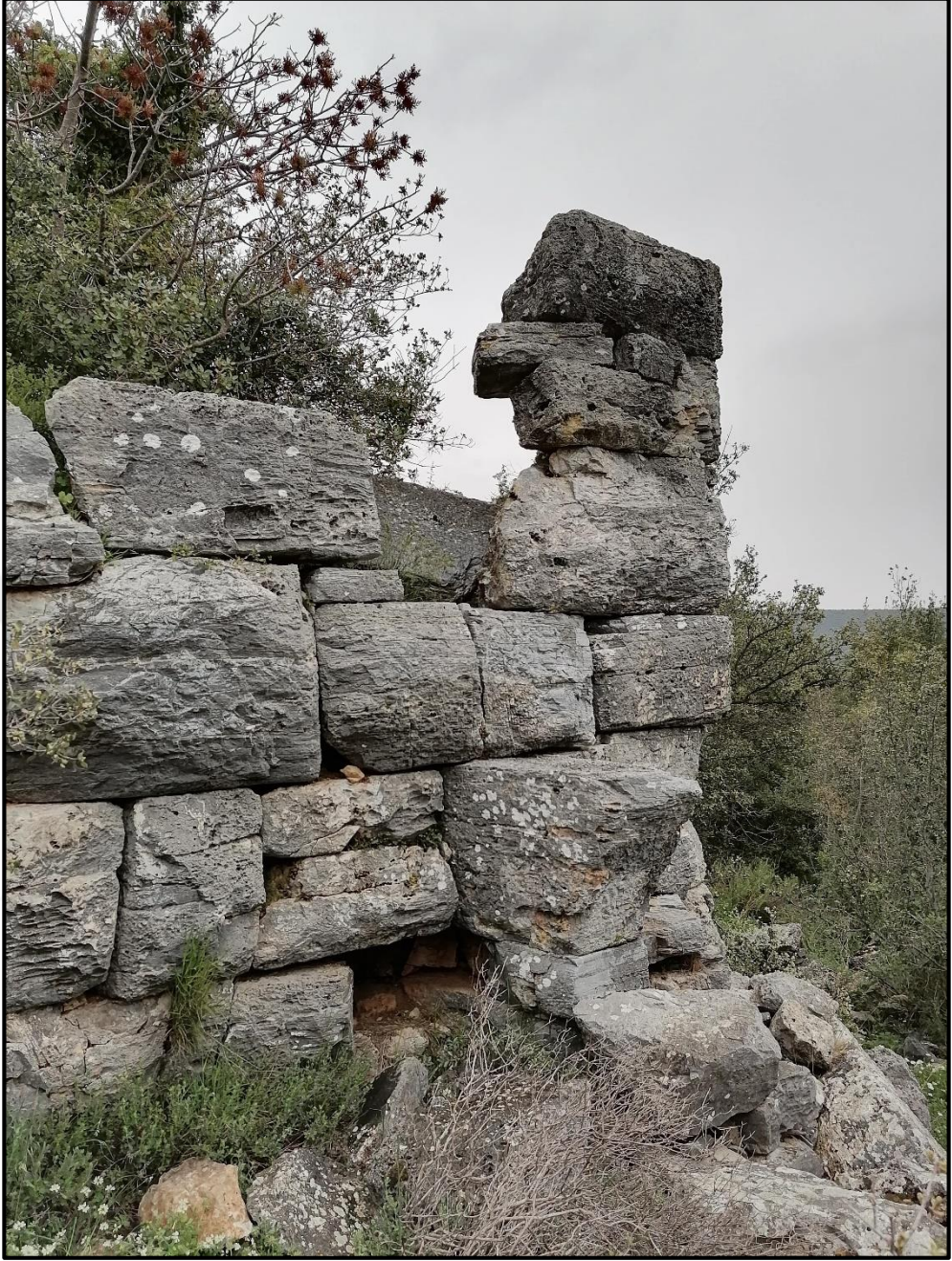
Resim 83: Barutçu köyünün kuzeyinde bulunan Helenistik Dönem kalenin merkezi kule cephesi.
