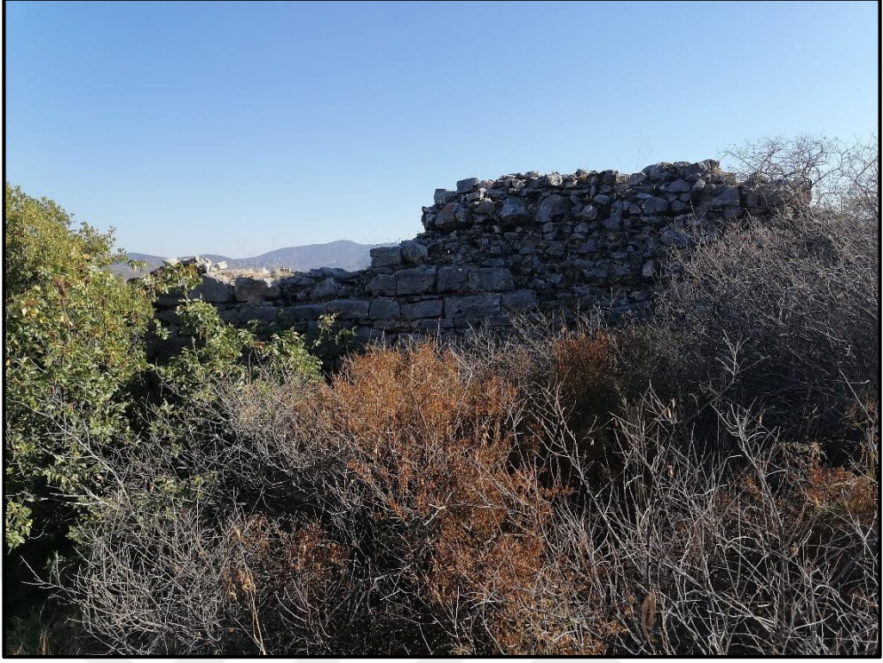
Resim 37: Panayır Dağı kuzey bölümü, Roma Çağı sur duvarlarının “opus caementicium” örgü iç cephesi tahrip olmuş alan içerisinde görünen beyaz kireç harç bağlayıcılı dolgu.
