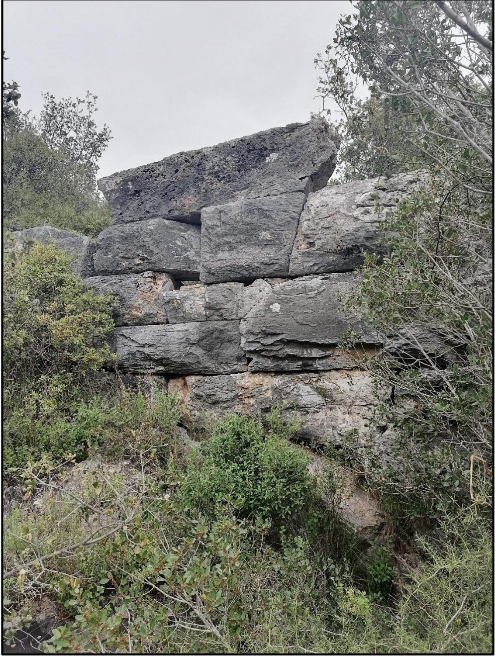
Resim 28: Barutçu Kalesi cephesi sur örgüsü detay, en üste konulan büyük boyutlu blok alttaki bloklarında kilitleme sistemi için yapılmıştır.
