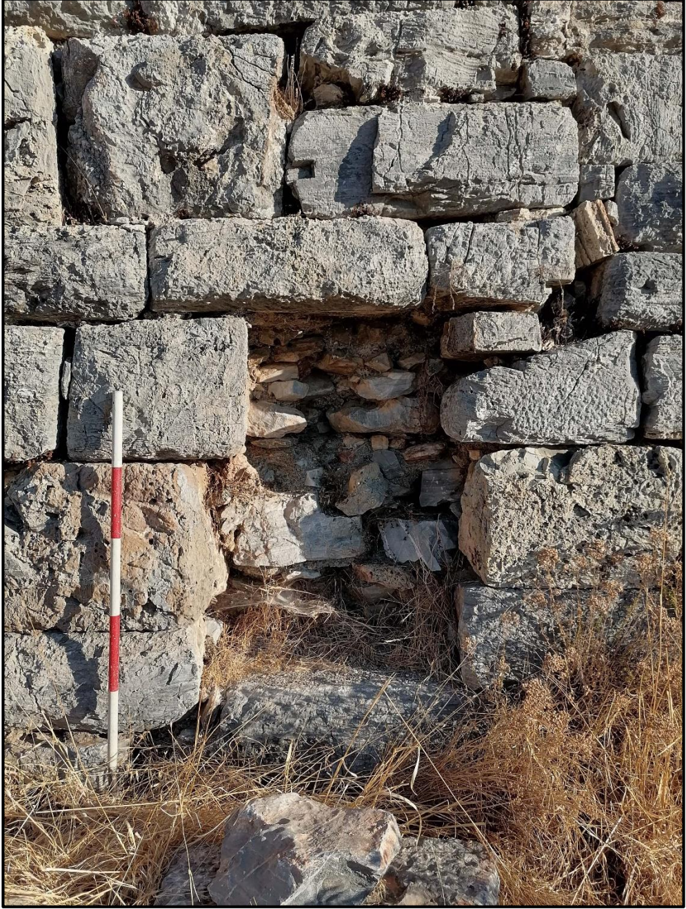
Resim 34: Panayır Roma Çağı sur duvarları örgü ve dolgu detayı.
