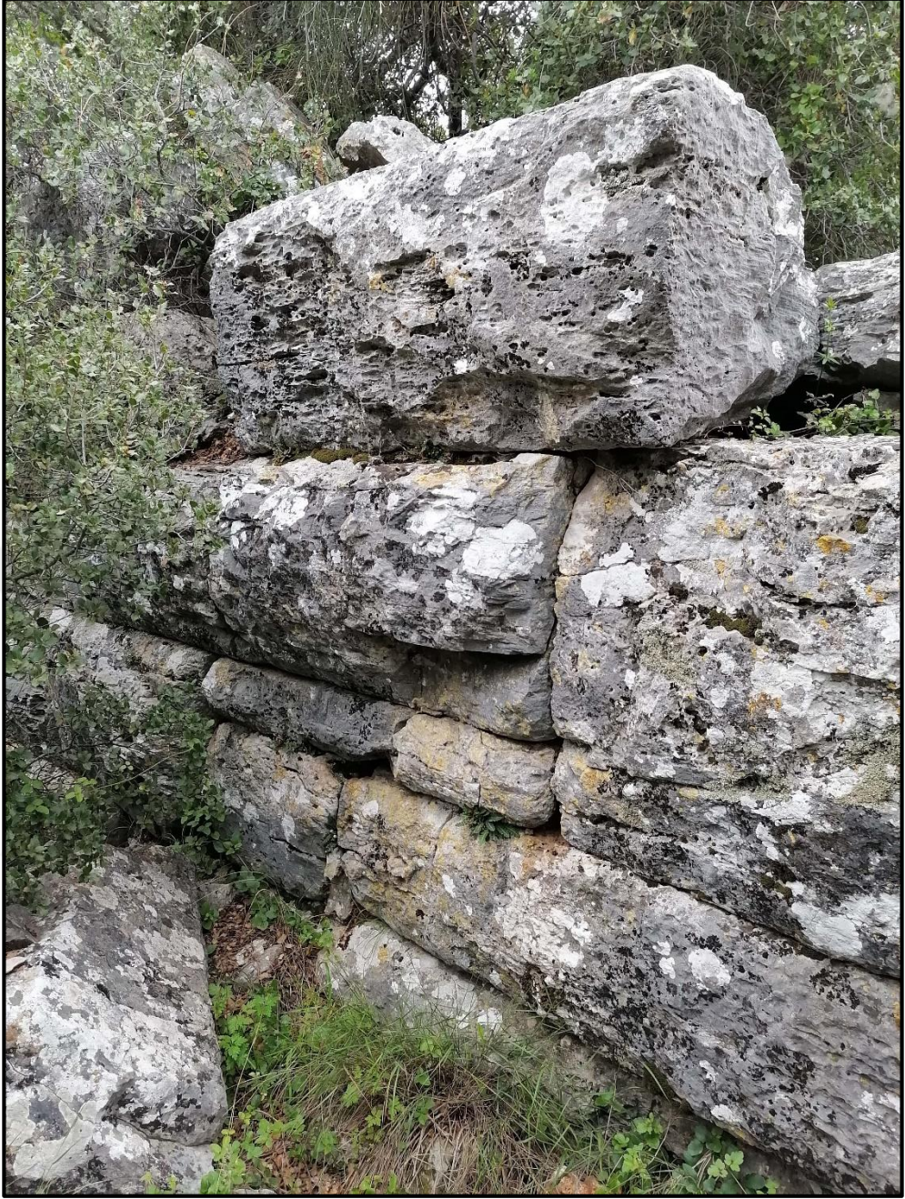
Resim 27: Barutçu Kalesi cephesi sur örgüsü detay.
