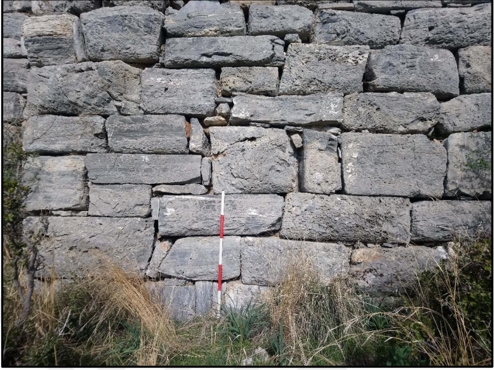
Resim 35: Panayır Roma Çağı sur duvarları boşluk alanlara sıkıştırılan yassı taş detayları.
