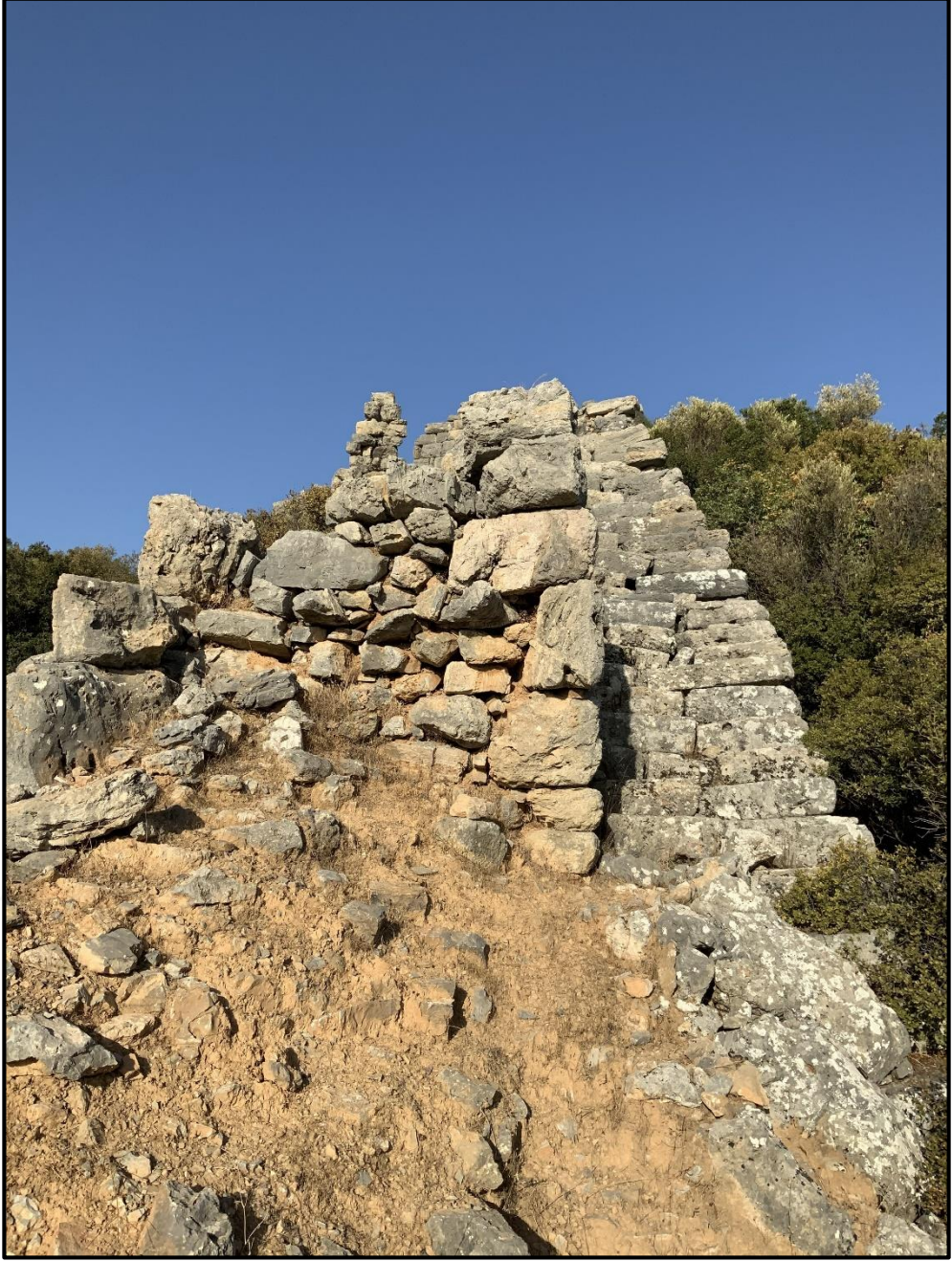
Resim 23: B lb l Dağı, solda sur i i dolgu kesiti, saėda ise seyirdim kısmına  ıkmayı saėlayan merdiven  rneėi.
