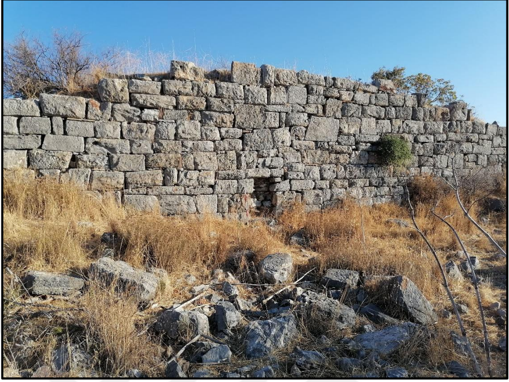
Resim 33: Panayır Roma Çağı sur duvarlarının çeşitli boyutta örgü blokları.
