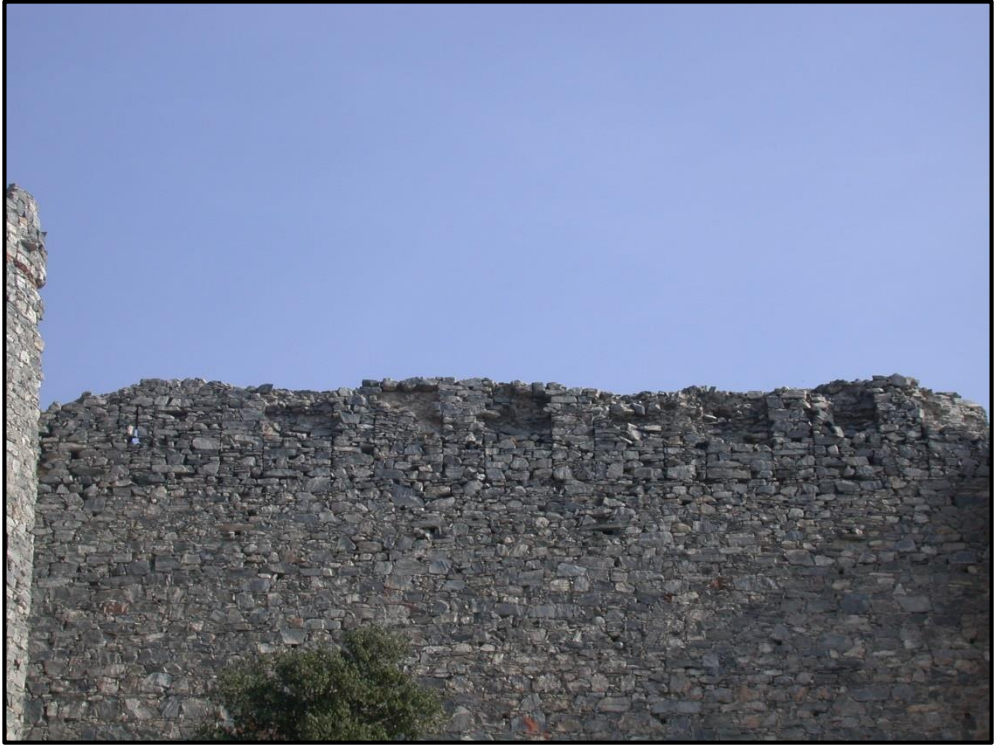
Resim 65: Keçi Kalesi denadan aralarının kapatılarak sur duvarının yükseltildiği evre (© E. Tok).
