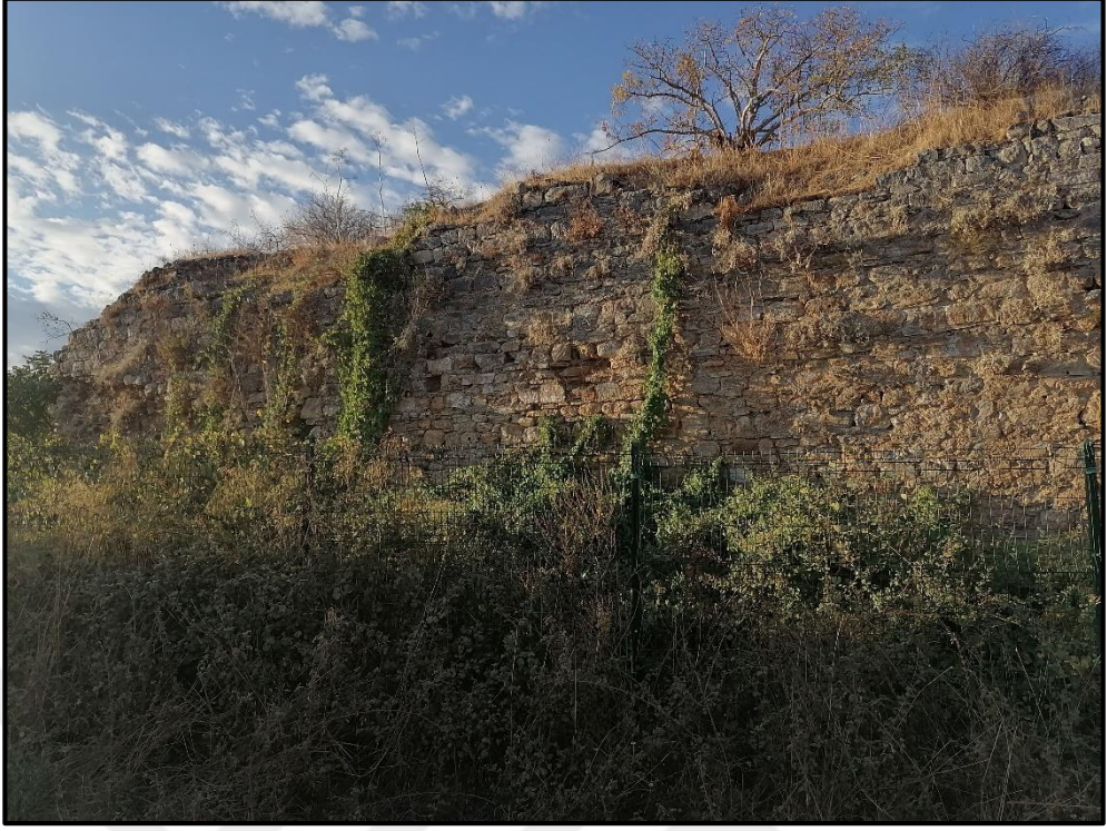
Resim 42: Ephesos Liman çevresi Roma Çağı kuzey kanat duvar örgüsü.
