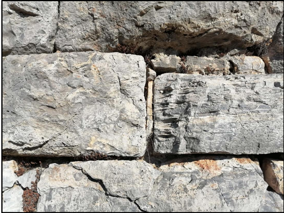
Resim 38: Helenistik Dönem sur duvarlarının deprem etkisi ile açılan derz aralarının Roma Dönemi'nde beyaz kireç harcı ve taş parçacıkları ile doldurulduğu Panayır Dağı kuzey bölümü surlarından detay.
