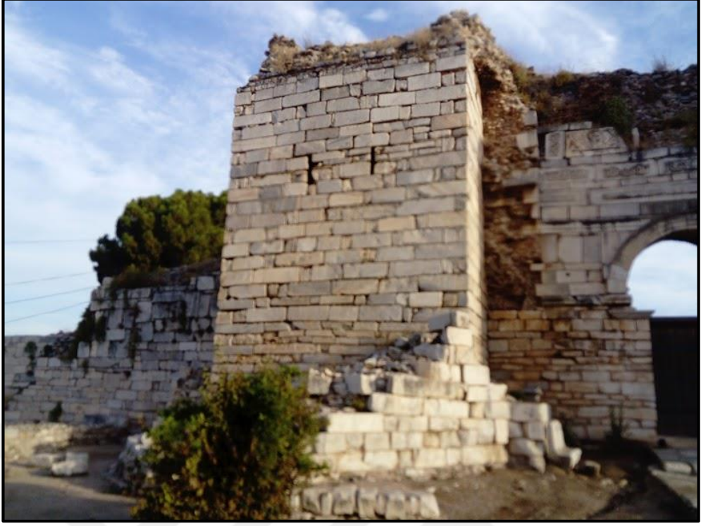
Resim 95: Ayasuluk tepesi dış surlar güney cephe M.S. VIII-IX. yy. evresi beşgen planlı kulenin zemin seviyesinde koruna gelmiş bölümü detay görüntüsü.
