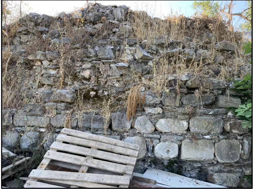
Resim 88: Ephesos liman çevresi Roma Çağı yuvarlak kule cephe örgü detayı.
