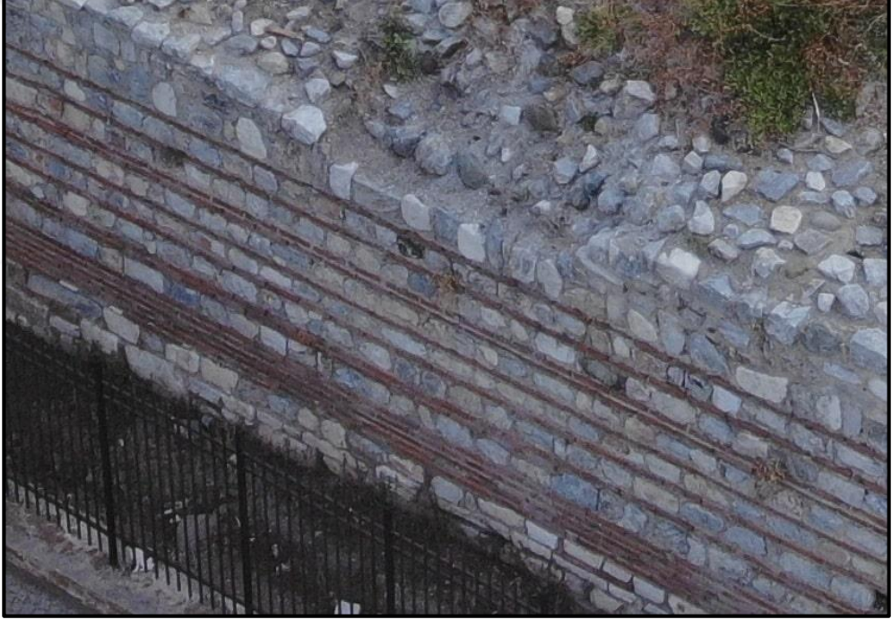
Res. 61: Tuğla taş almasıık duvar örgü detay.
