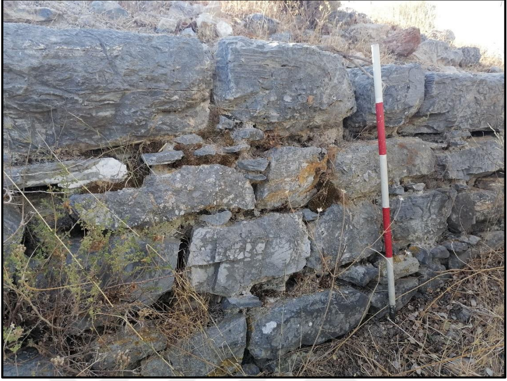
Resim 40: Panayır Dağı kuzey bölümü, Roma Çağı sur duvarlarının “opus caementicium” örgü iç cephesi özensiz örgü detayı.
