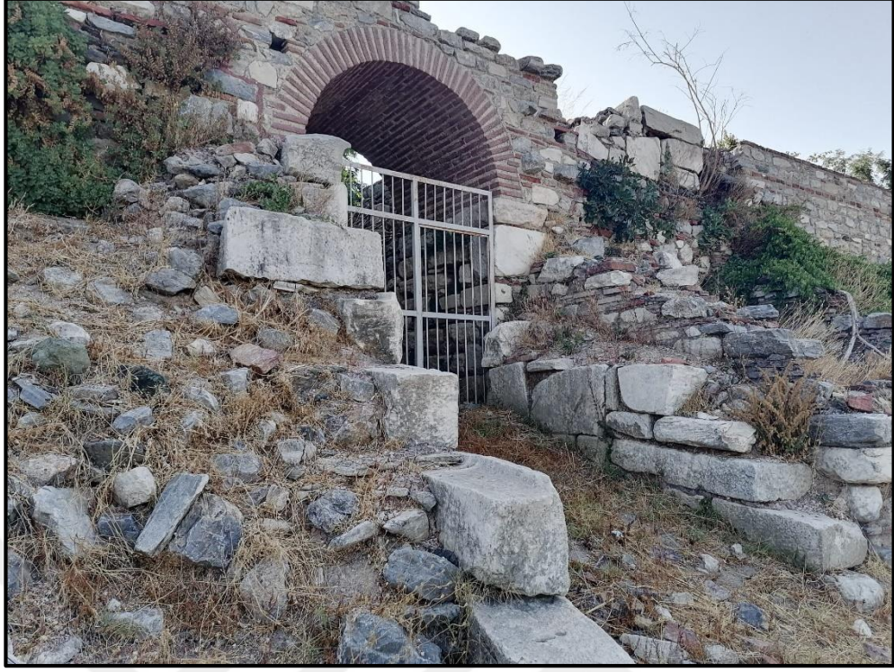
Res. 132: Ayasuluk Tepesi batı surları, kuzeybatı giriş kapısının ikinci evrede de bir hol ile kullanımına devam edilmiş.
