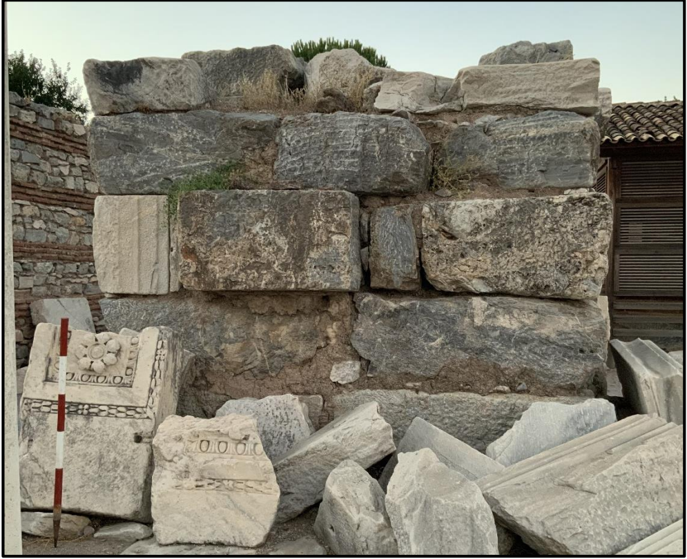
Resim 9: Aziz Yuhanna Kilisesi Iustinianus Dönem’i kubbe ayaklarında devşirme malzeme olarak kullanılan Helenistik Dönem sur blokları.
