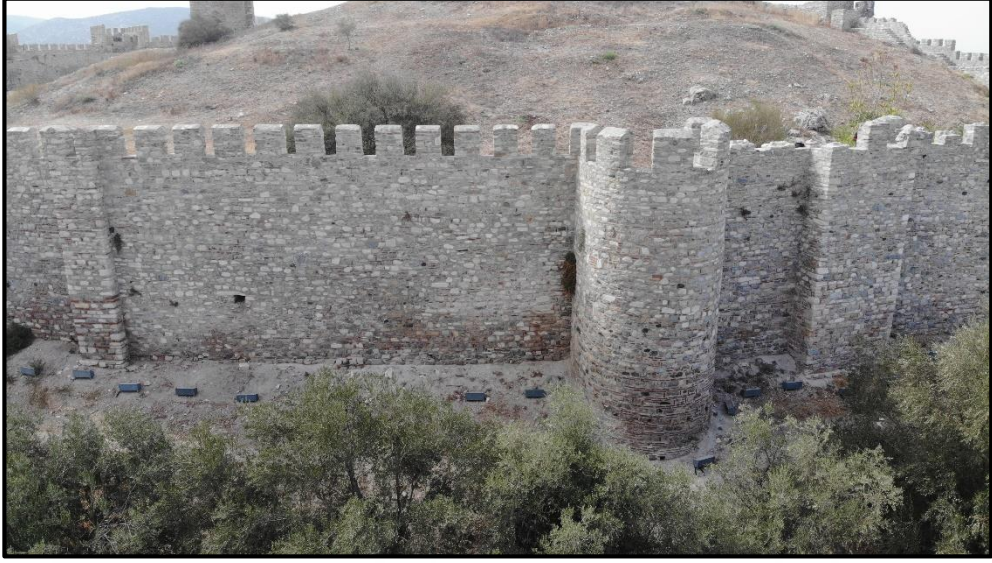
Resim 66: Ayasuluk iç kale doğu sur duvarları moloz duvar örgüsü.
