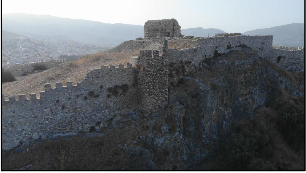
Resim 106: Ayasuluk iç kalesi kuzeybatı surları Beylikler dönemi yığma duvar kare formlu kule.
