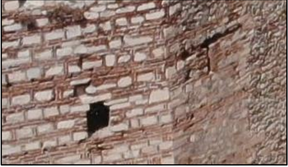
Resim 62: Ayasuluk iç kale surlarının çerçeve örgü üslubu detayı.
