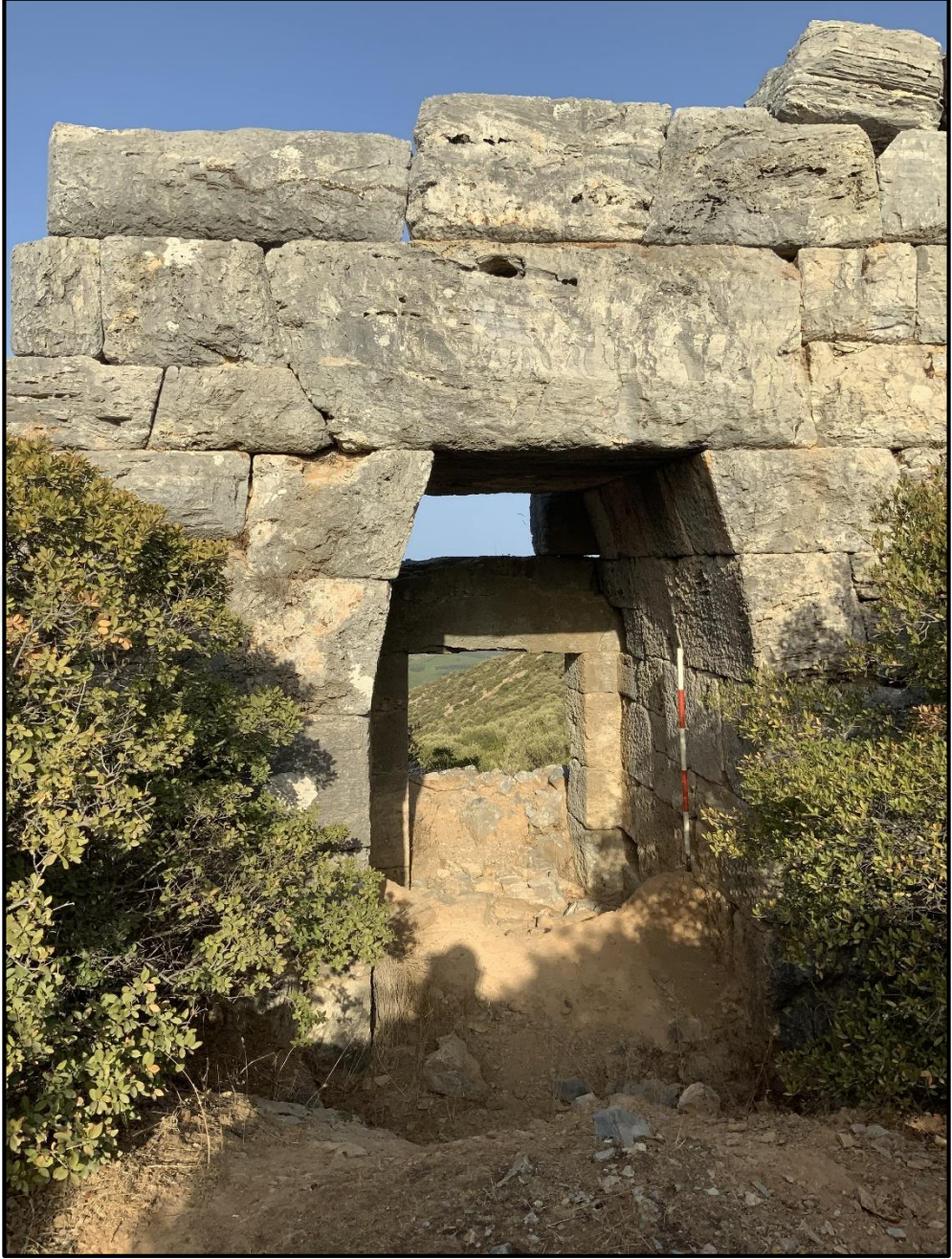
Resim 110: Blbl Dađı dođu surları, trapezoidal sve blokları ile yapılmıř altıgen formunda postern kapı tipi.
