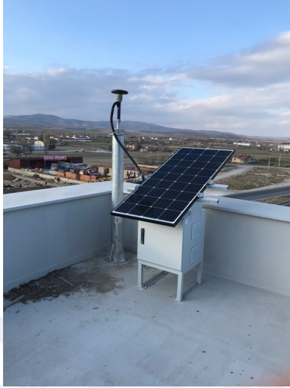
Resim 6.3 BBEL sabit GNSS istasyonu (Bolvadin belediye binası terası).
