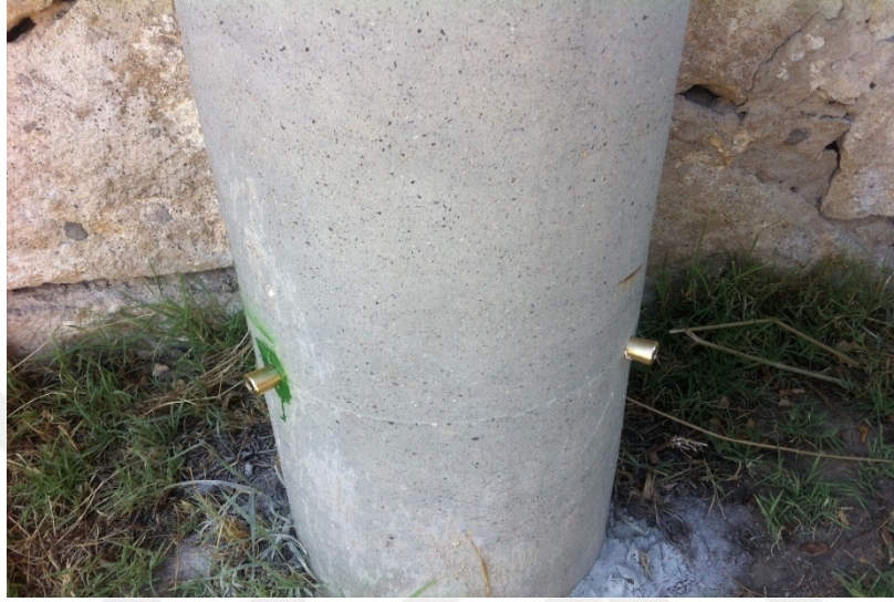
Resim 6.6 Beton elektrik direği üzerindeki nivelman araçları (Tiryakioğlu 2019).
