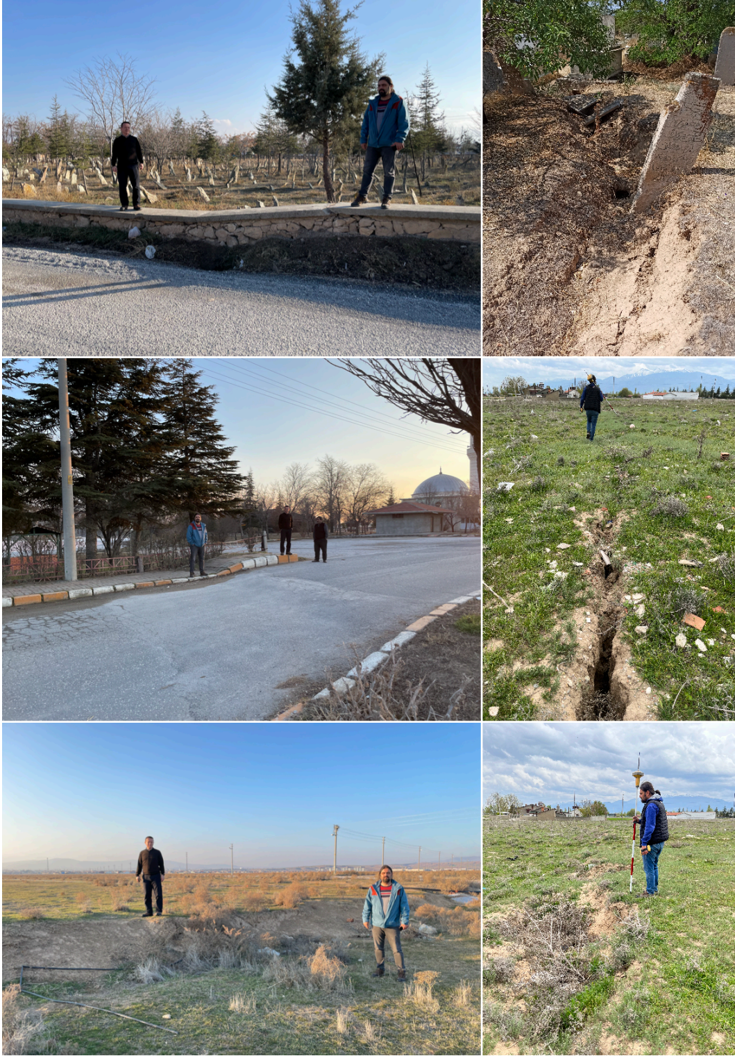
Resim 3.2 Bolvadin ilçesinde gözlenen yüzey deformasyonları.
