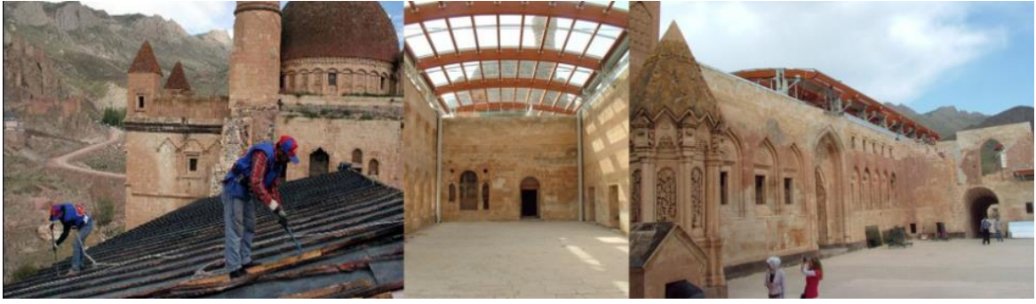
Şekil 43. Ahşap konstrüksiyon ve metal örtünün çıkarılması, ahşap yapılı cam çatı uygulaması (Bulat 2014)
