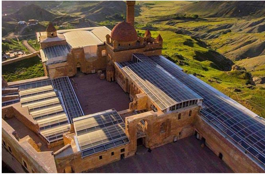
Şekil 44. Ahşap yapılı cam çatı uygulaması (Anonim 2022z)
