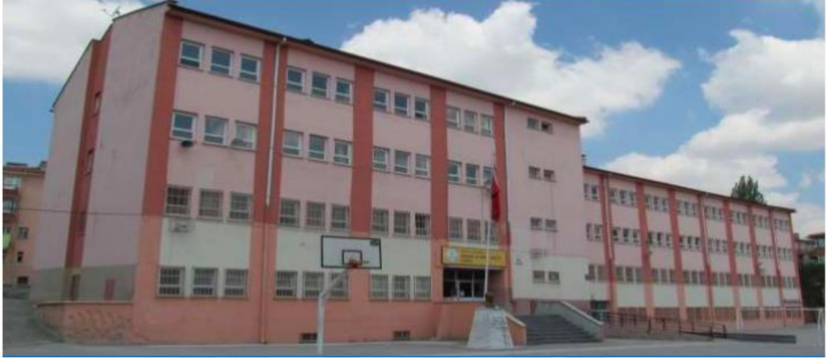
Şekil 3. Keçiören Anadolu İmam Hatip Lisesi Binası
