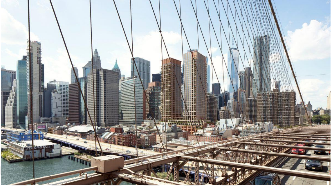
Şekil 2.4. South Street Seaport dönüşüm projesi (Anonim 8)
