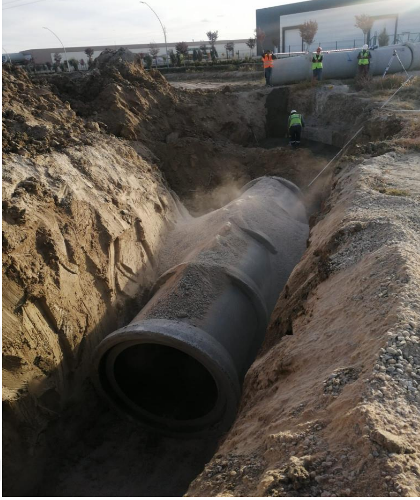
Şekil 4.11. Entegre contalı betonarme boru
