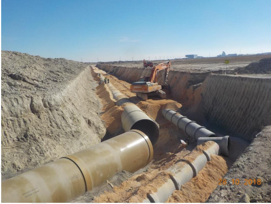
Şekil 4.12. Cam elyaf takviyeli polyester boru
