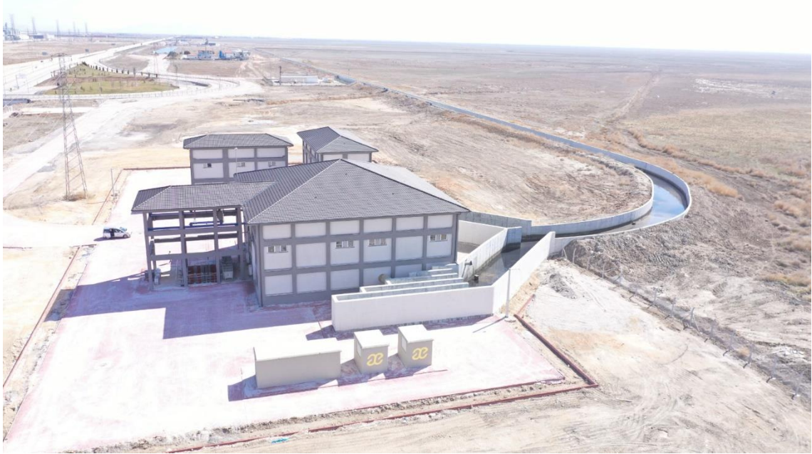
Şekil 4.40. Atık su, yağmur suyu ve gri su terfi istasyonu
