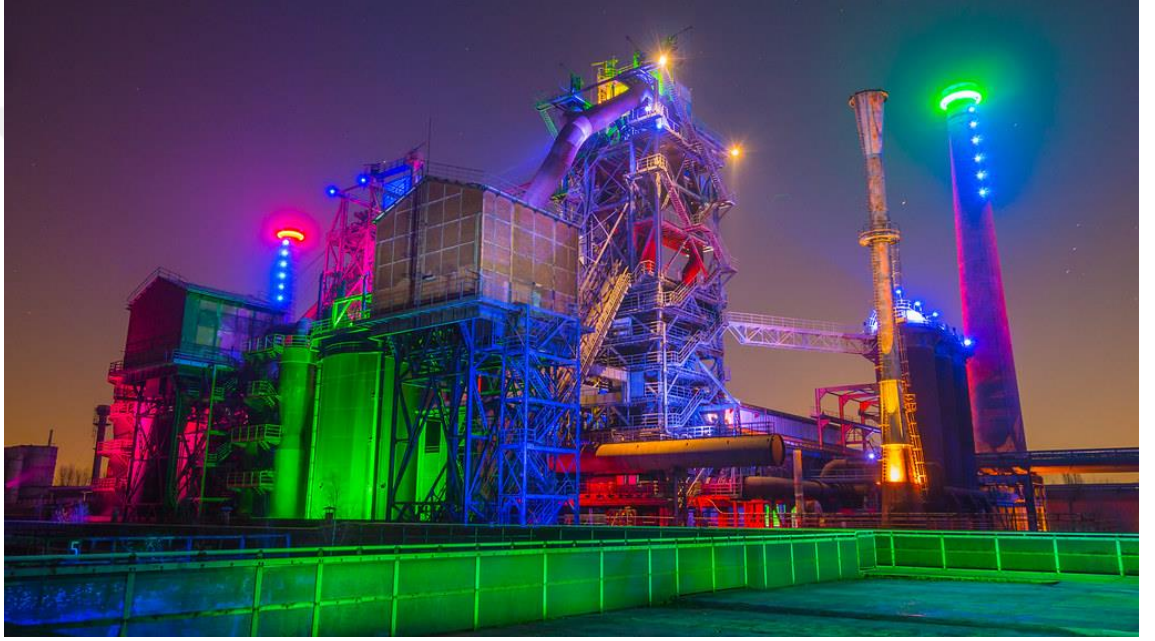
Şekil 2.5. Emscher Park eğlence merkezi (Anonim 9)
