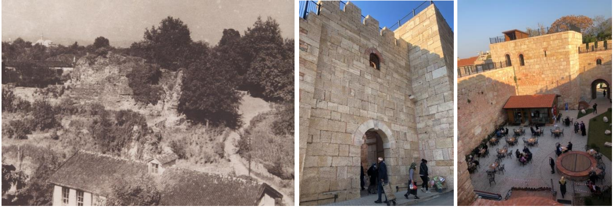
Şekil 39. Restorasyon öncesi ve sonrası Zindan Kapı.
