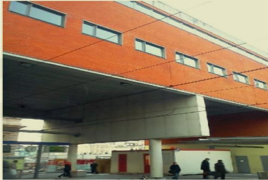
Şekil 2.4. Derin kiriş uygulaması ile yüklerin kolonlara aktarılması (Yılmaz, 2016'dan akt. I.M Boyan ve ark., 2013)
