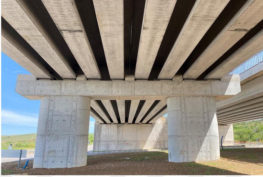
Şekil 2.5. Köprülerde tek açıklıklı derin kiriş uygulaması (Orijinal).
