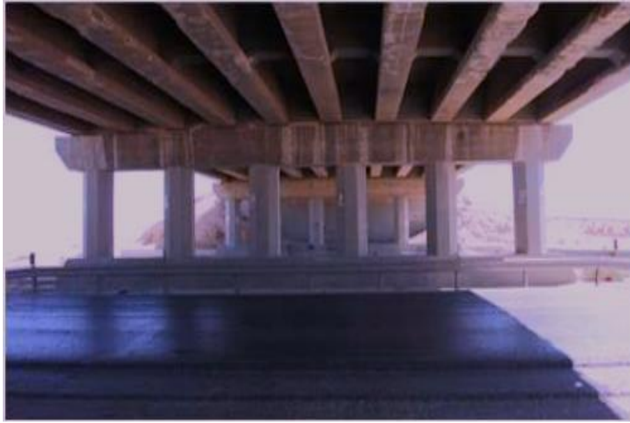
Şekil 2.6. Köprülerde birden çok açıklıklı derin kiriş uygulaması (Al-Baijat ve Alhawamdeh, 2019).
