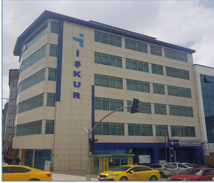
Şekil 0-2. Erzurum Çalışma İş Kurumu İl Müdürlüğü hizmet binası
