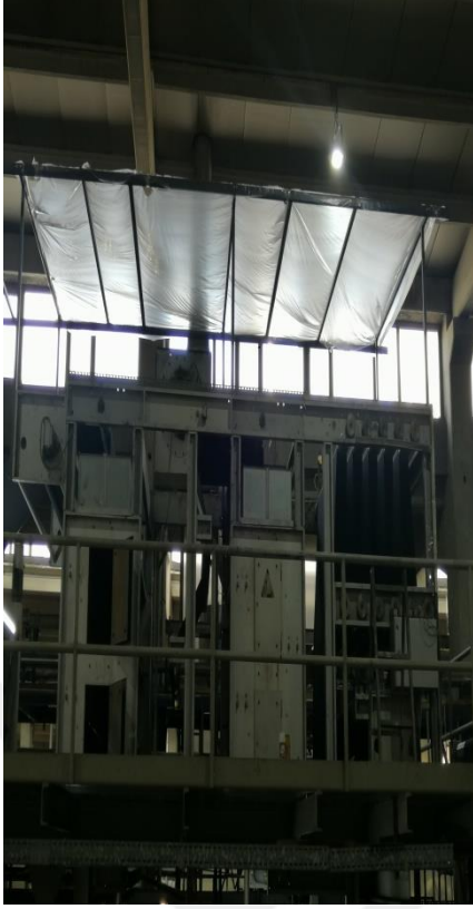
Şekil 3.10. Havalandırma ve Infrared
