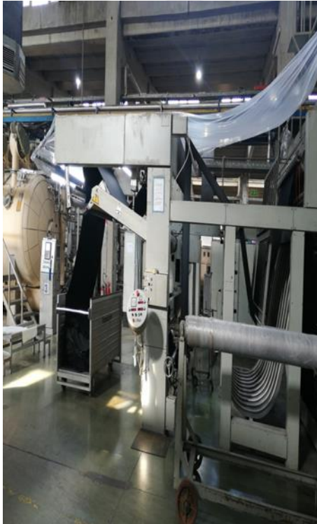
Şekil 3.12. E-Kontrol Çıkış J-box ve Sarım Ünitesi
