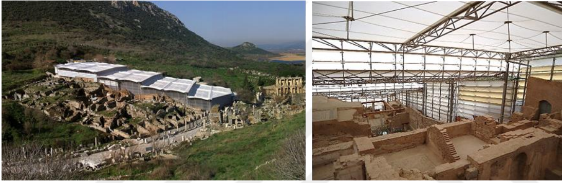
Resim 4.9. Solda Yamaç Ev 2'nin Panayır Dağı'ndan görünümü (URL 7) ve sağda, koruma binası cephe lamelleri ve örtüsünün 2021 yılına ait görünümü (Kişisel Arşiv).
