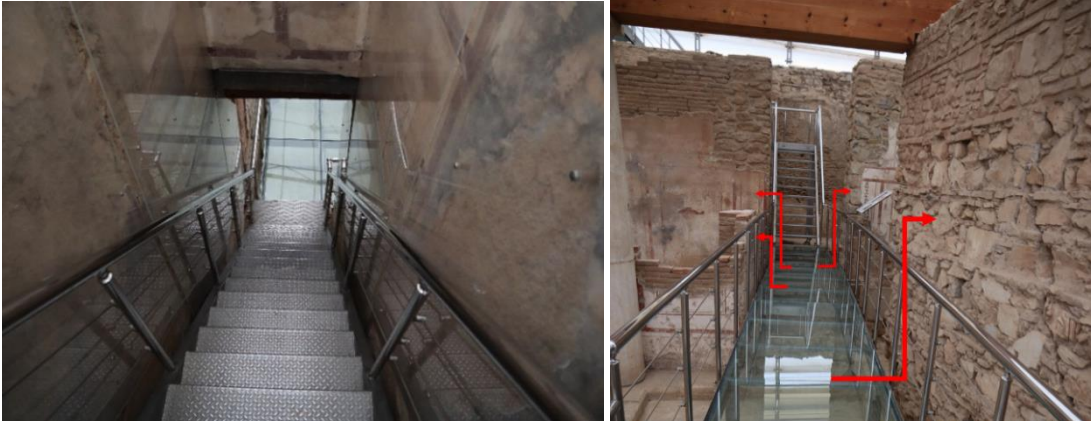
Resim 5.24. Solda, konut birimi 6, 32a mekanından geçen merdivenlerde, duvar resimleri üzerine yerleştirilen şeffaf pleksiglas plakalar ve sağda, konut birimi 2 SR 27 mekanı batısından geçen ziyaretçi yolunda temasa açık duvar ve duvar resimleri (Kişisel Arşiv).
