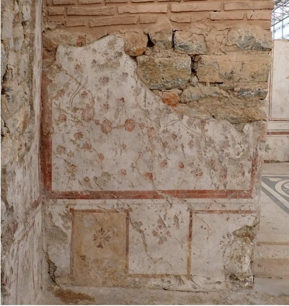
Resim 4.15. Konut birimi 2, SR 14 batı duvarı güneyi, 2022 yılı duvar resmi koruma ve onarım çalışmaları, temizlik uygulamaları sonrası görünümü (Ephesos Yamaç Ev 2 Koruma-Onarım Projesi Arşivi).
