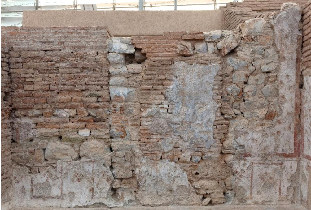
Resim 5.6. Konut birimi 2, SR 14 güney duvarı, yapısal çatlaklar ve duvar resminde parça kayıpları, 2022 yılında görünümü (Ephesos Yamaç Ev 2 Koruma-Onarım Projesi Arşivi).
