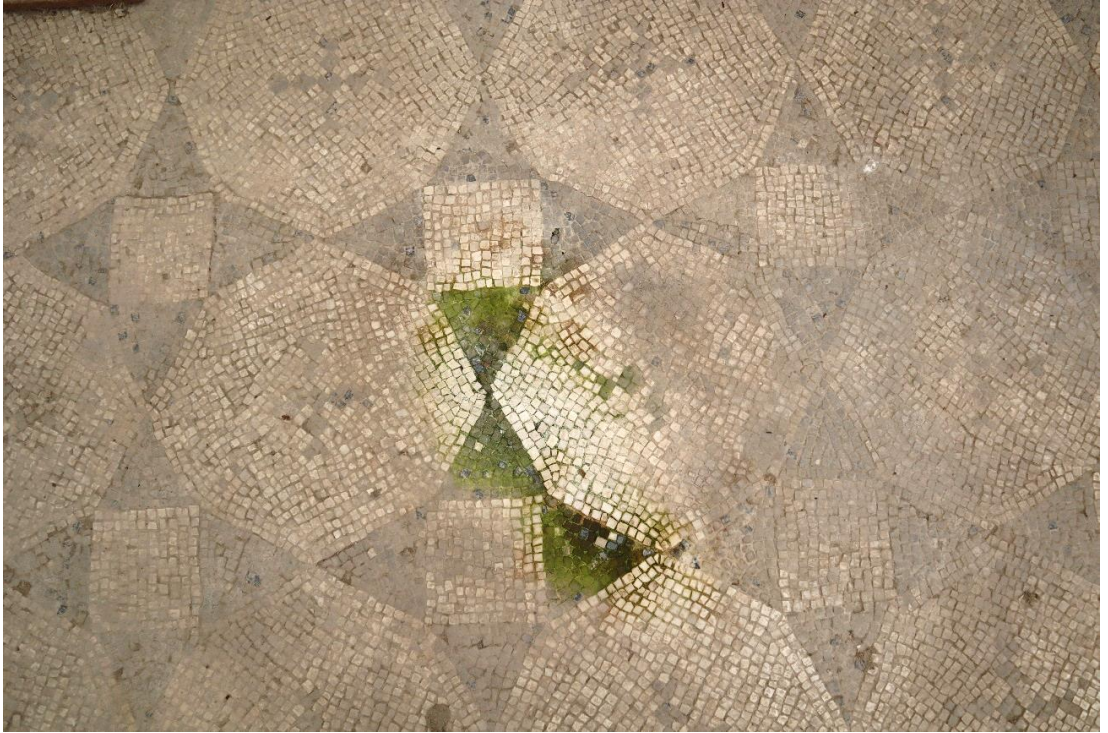
Resim 5.18. Konut birimi 7, 32e mekanı zemin mozağı üzerine düşen suyun etkilediği alan ve bu alanda mikroorganizma gelişimi (Kişisel Arşiv).
