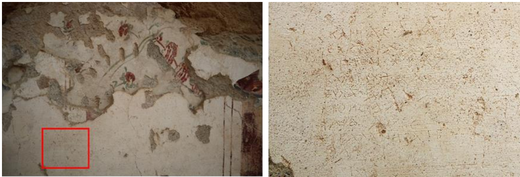
Resim 3.2. Konut birimi 3, 16a mekanı batı duvarına kazınan graffito ve detay görünümü (Kişisel Arşiv).
