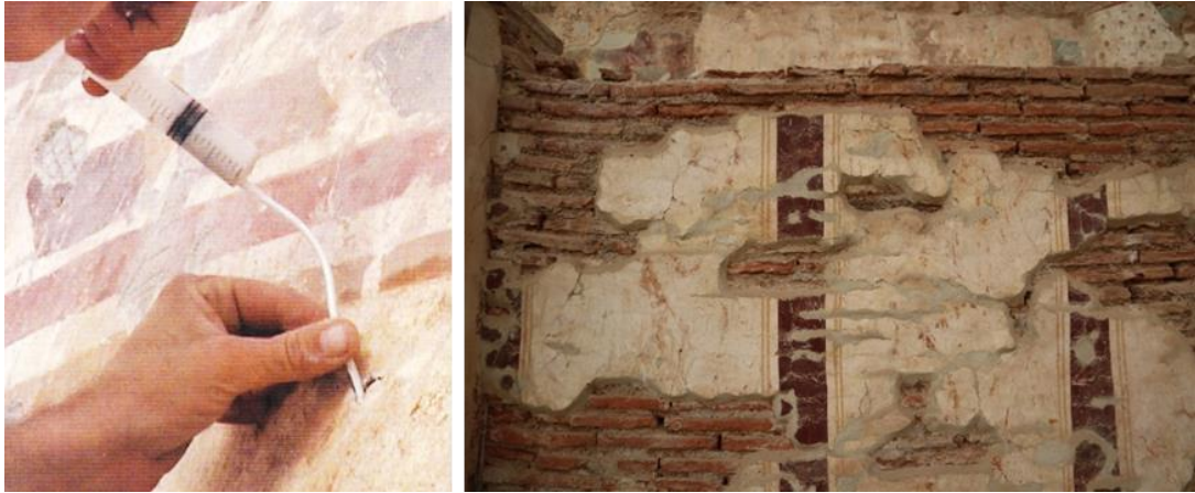
Resim 4.3. Solda, sıvı harç enjeksiyonu uygulaması (Herold, 2015, s. 303) ve sağda, konut birimi 4, 21, Güney duvarı doğusu, lakuna ve bordür harcı uygulamalarının 2021 yılına ait görünümü (Kişisel Arşiv).
