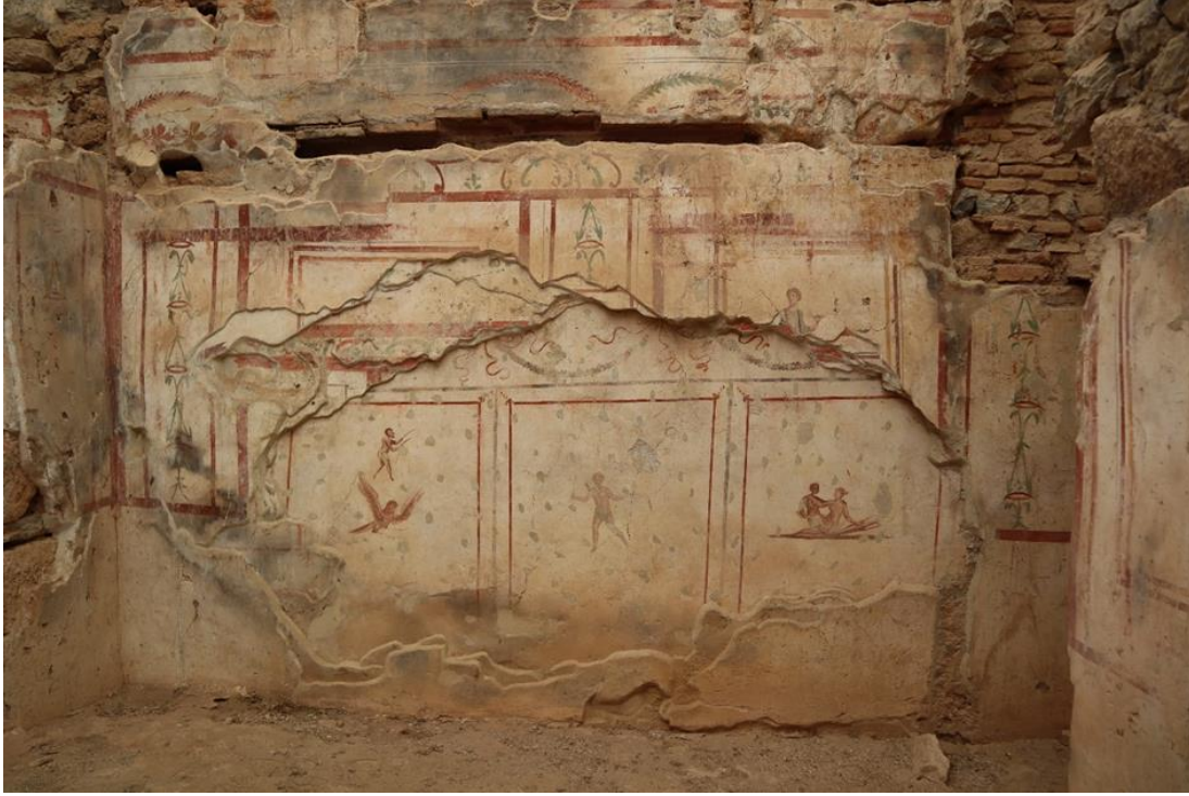
Resim 3.11. Konut birimi 7, 45b mekanı doğu duvarı, üstü üste yedi sıva ve sekiz boya tabakası (Kişisel Arşiv).
