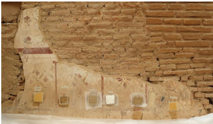
Resim 4.14. Konut birimi 2, SR 14 doğu duvarı, 2022 yılı duvar resmi koruma ve onarım çalışmalarında kimyasal temizlik öncesinde spot test uygulamaları (Ephesos Yamaç Ev 2 Koruma-Onarım Projesi Arşivi).
