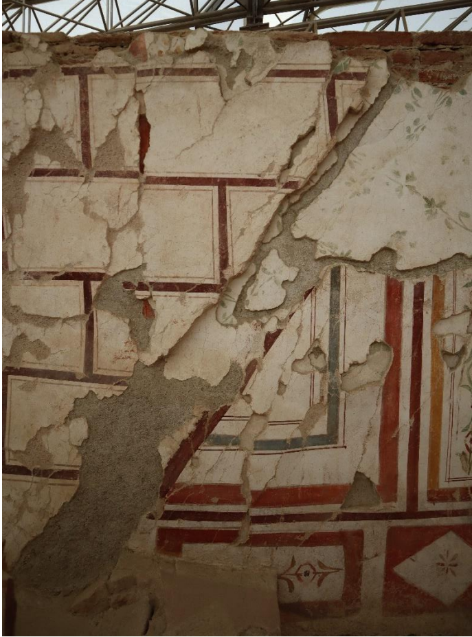
Resim 3.12. Konut birimi 5, mekan 18 doğu duvarının kuzeyi, farklı duvar resmi katmanları ve merdiven izi (Kişisel Arşiv).
