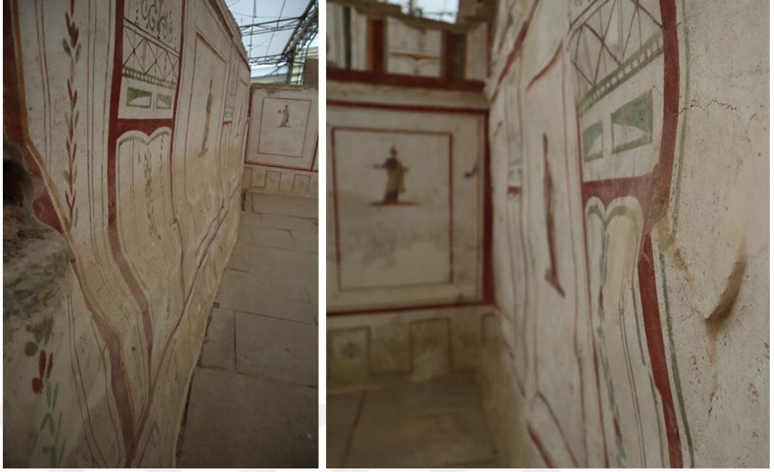
Resim 5.8. Konut birimi 3, 12 (Musalar odası) duvar resimlerinde görülen deformasyonlar; solda, kuzey duvarı ve sağda; güney duvarı (Kişisel Arşiv).
