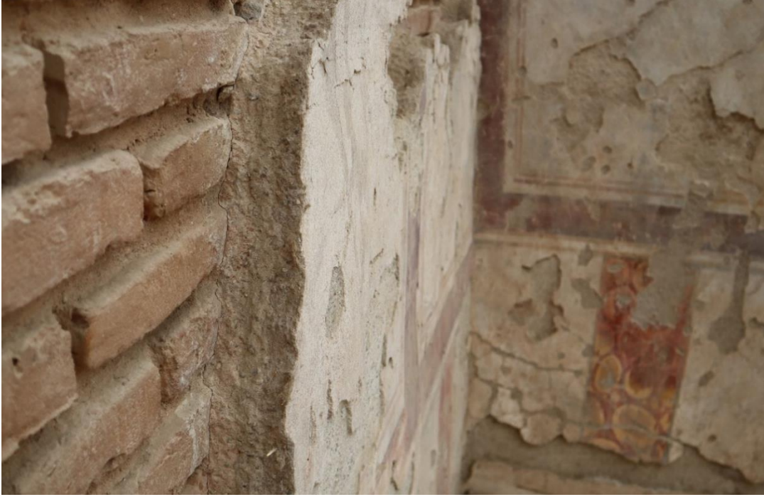
Resim 4.11. Detay, konut birimi 2, SR 28batı duvarı, üç katmanlı arriccionun harç onarımları sonrası görünümü (Kişisel Arşiv).
