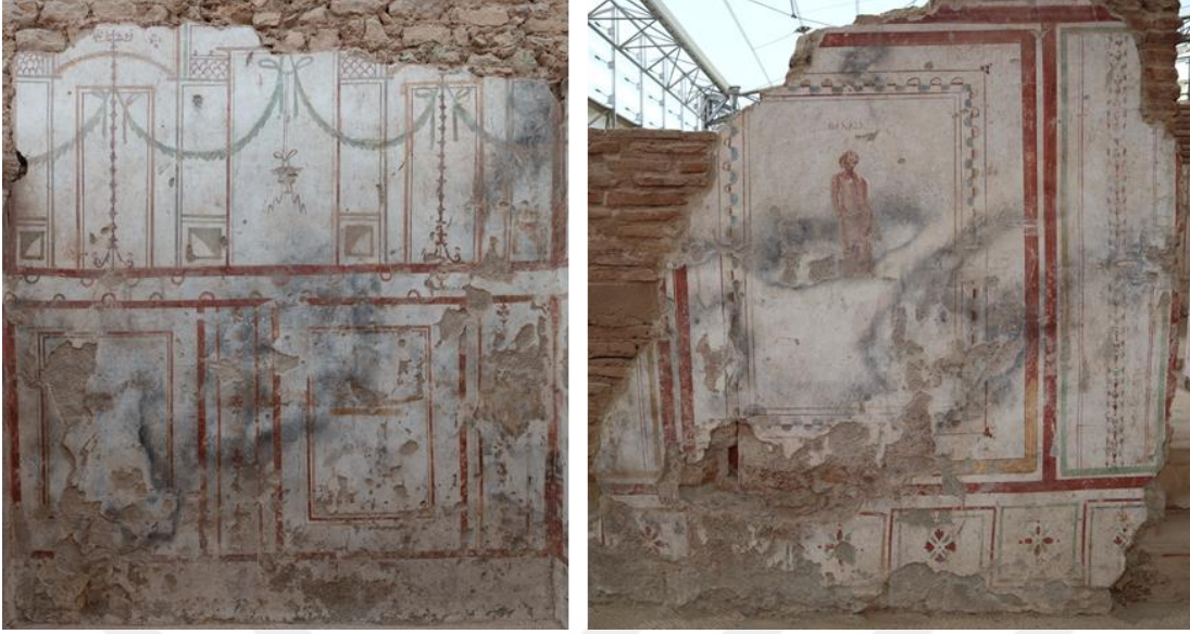
Resim 5.9. Konut birimi 2, yangın izleri; solda, SR 26 güney duvarı ve sağda, SR 20 doğu duvarının güneyi (Kişisel Arşiv).
