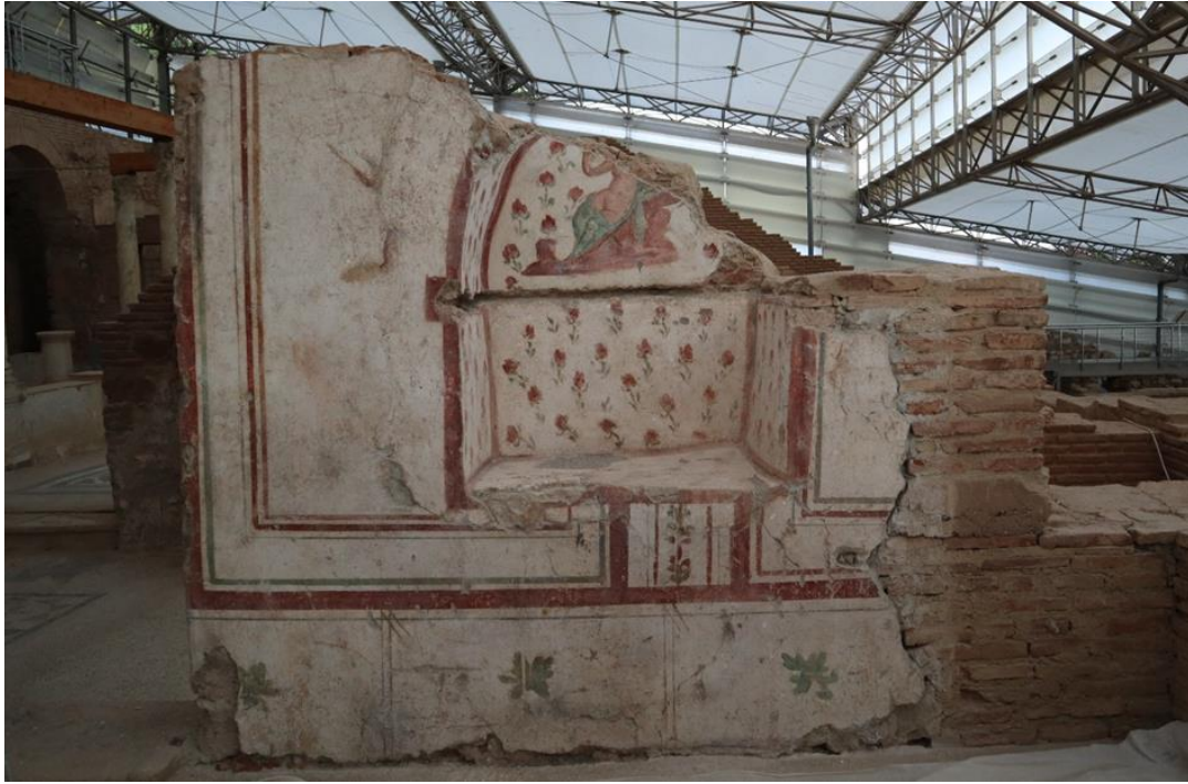
Resim 3.13. Konut birimi 2, SR 18 batı duvarı, mekan giriş çıkışının değiştirilmesi ardından açılan niş ve değişen duvar dekorasyonu (Kişisel Arşiv).
