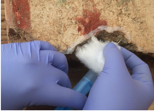
Resim 4.16. Detay, Konut birimi 2, SR 18, 2019 yılı koruma ve onarım çalışmalarında arriccio tabakasında nano kireç dispersiyonu ile sağlamlaştırma uygulaması (Ephesos Yamaç Ev 2 Koruma-Onarım Projesi Arşivi).
