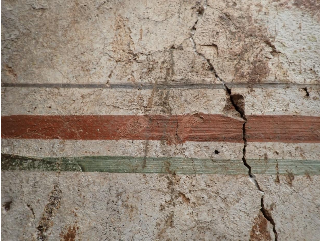
Resim 3.8. Detay, konut birimi 2, SR 26 kuzey duvarı, yaş sıva üzerine bırakılmış parmak izleri, hizalama ipi izi ve fırça izleri (Kişisel Arşiv).
