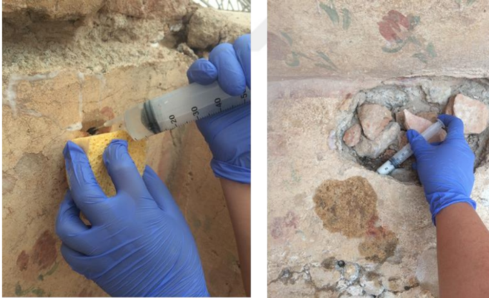
Resim 4.12. Konut birimi 2, SR 18 batı duvarı 2019 yılı duvar resmi koruma ve onarım çalışmaları, etanol- su çözeltisi ve sıvı harç enjeksiyonu uygulamaları (Ephesos Yamaç Ev 2 Koruma-Onarım Projesi Arşivi).
