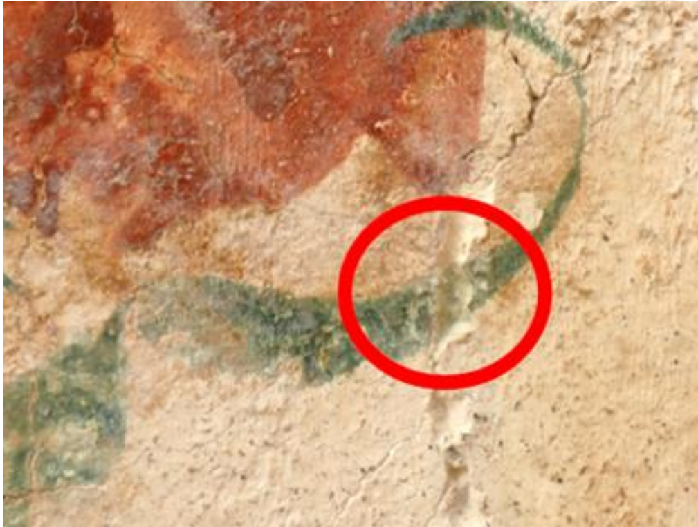
Resim 4.18. Detay, konut birimi 2, SR 18, 2019 yılı koruma ve onarım çalışmaları, batı duvarı onarımında kullanılan intonaco harcı üzerinde rötuş uygulaması (Ephesos Yamaç Ev 2 Koruma-Onarım Projesi Arşivi).
