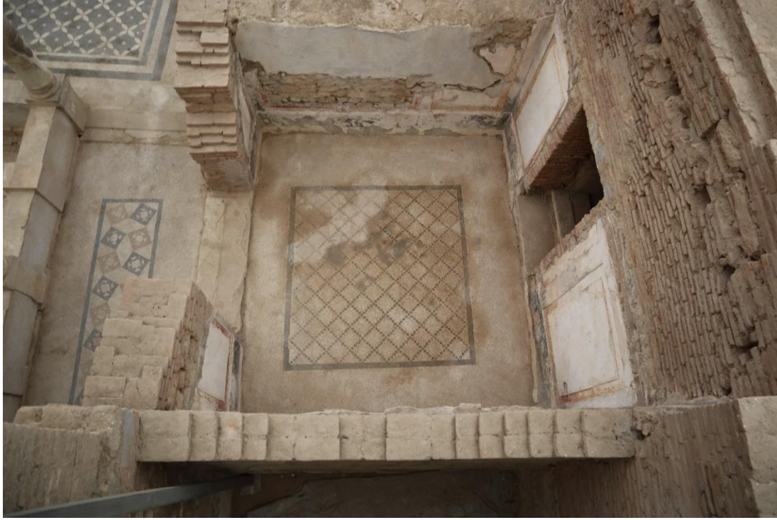
Resim 5.15. Konut birimi 2; 26.11.2021 tarihinde gerçekleşen yağış ardından, konut birimleri içerisine sızan suyun SR 16 mekanı mozaikinde sebep olduğu ıslanma (Kişisel Arşiv).
