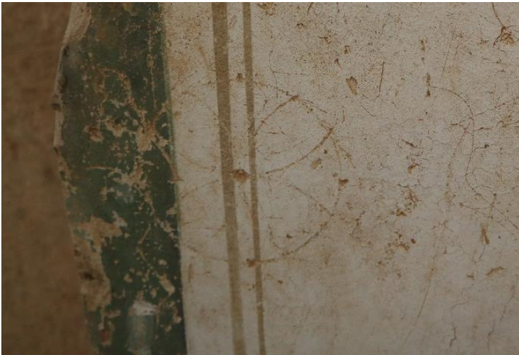
Resim 2.10. Detay, Ephesos, Yamaç Ev 2, konut birimi 7, 38 b mekanın doğu duvarından pergel izi (Kişisel Arşiv).
