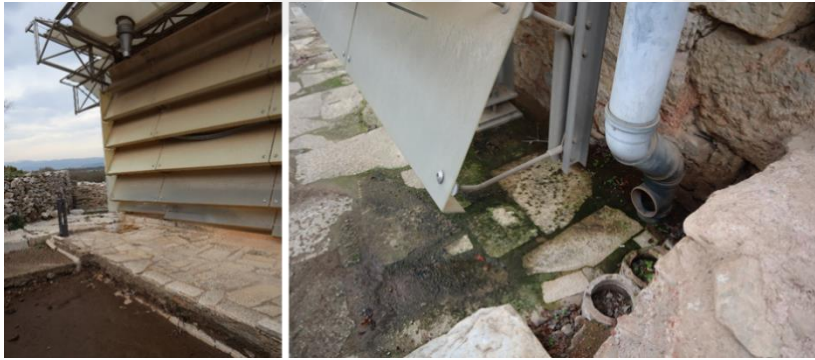
Resim 6.2. Konut birimi cephelerine yağmur suyu tahliyesi yapan bazı drenaj hatları; solda, örtünün güney batı köşesi ve sağda batı cephede bulunan drenaj iniş borusu (Kişisel Arşiv).
