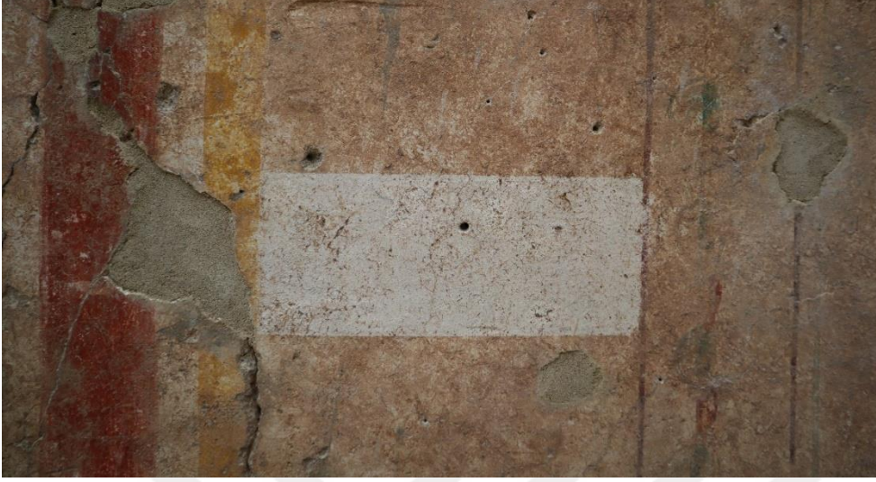
Resim 4.4. Detay, konut birimi1, SR 10a doğu duvarında temizlik denemesi yapılmış olan alan (Kişisel Arşiv).
