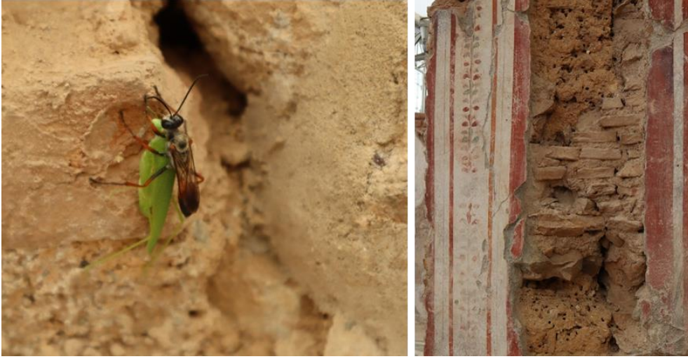
Resim 5.26. Konut birimi 2; solda, SR 14 güney duvarına açtığı yuvaya yakaladığı çekirgeyi taşıyan yaban arısı ve sağda, SR 19 doğu duvarında görülen böcek galerisi giriş çıkış delikleri (Kişisel Arşiv).
