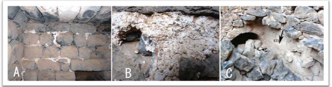
Şekil 4. A) Bozulmamış beyaz harç (örnek S3) dolgusu odanın taşları arasındaki derzler (27); B) yakınavlu S2 örneğinin (24) in situ harcının görünümü; C) kemere uygulanan alçı tabakası (örnek S11) ve bindirmenin altındaki 6 numaralı odanın duvarı.
