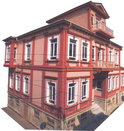
Şekil 5.16 Sağlık İl Müdürlüğü Binası
