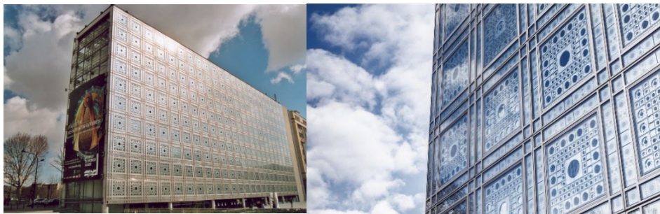
Şekil 2. 29: Arap Enstitü Binası, Genel görünüş solda), Yapı cephesi yakından görünüş (sağda) (Url-27, 2020).
