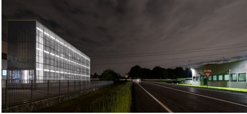
Şekil 3.9: Deponun gece ışıklandırması ile otoyol aksında dikkat çekici görünütüsü (Url-38, 2022).
