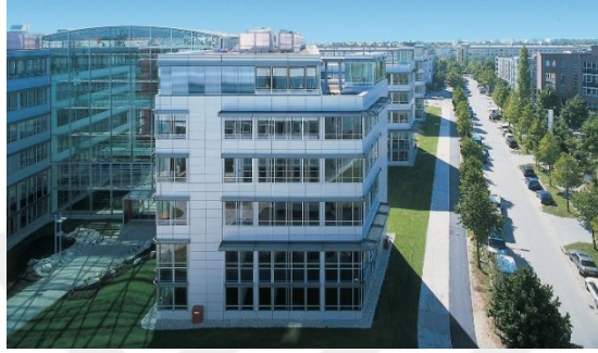
Şekil 2.30: Aviva Binası Genel görünüş (Url-24, 2020).
