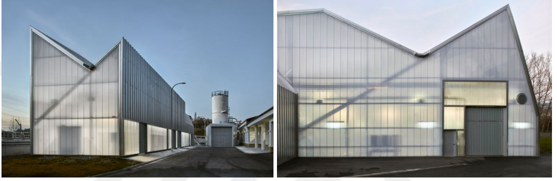
Şekil 3.7: Kanalizasyon Arıtma Tesisi, İspanya, yapı cephesinin dışarıdan görünümü (Url-36, 2022).
