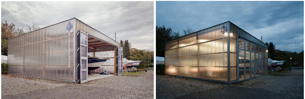
Şekil 3.8: Kayıkhanesi yapısının gündüz (solda) ve akşam (sağda) görünümü (Url-37, 2022).
