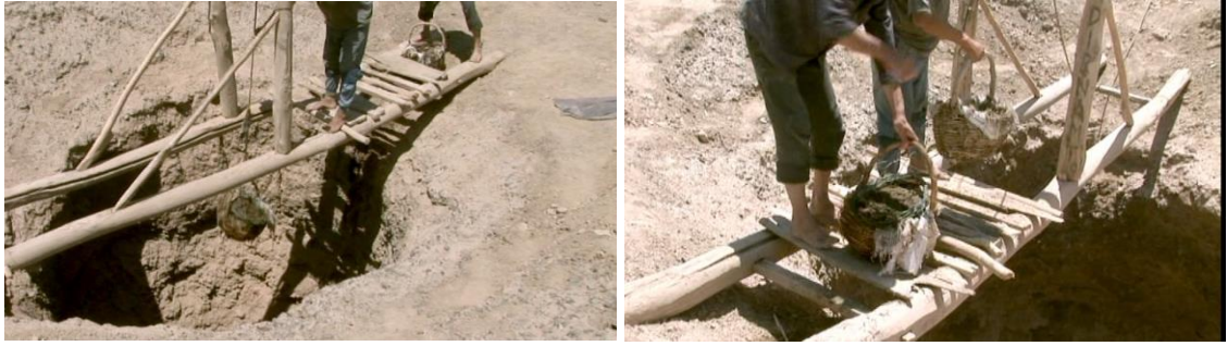
Görsel 24-25: Karız sepetiyle çıkartılan çamur, toprak (Tahur 2012).
